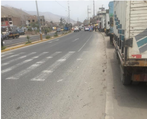
Foto 7 LFoto 8 Material y grava en las pistas
