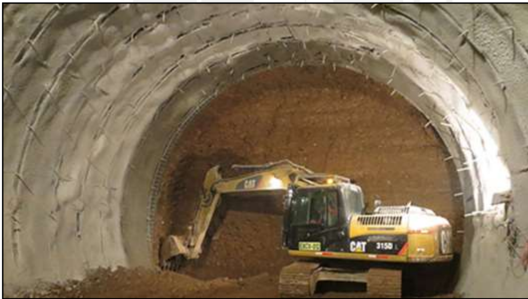
Figura 20: Excavación de túnel por medios mecánicos.[18]
