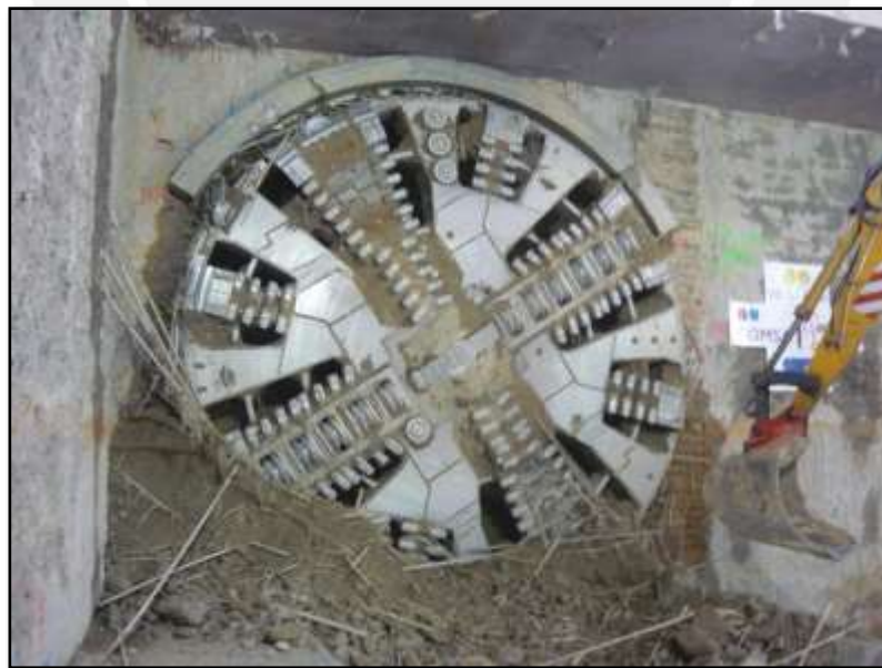
Figura 21: Escudo EPB rompe muro de estación en el Metro de Barcelona [18]
