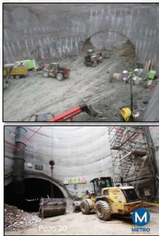
Figura 28-29: Avance de la Línea 2 del Metro de Lima [21]
