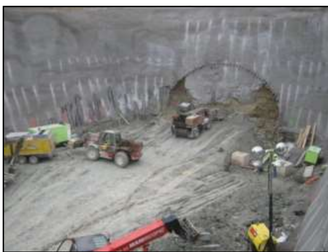
Figura 1: Emboquille convencional [2]
