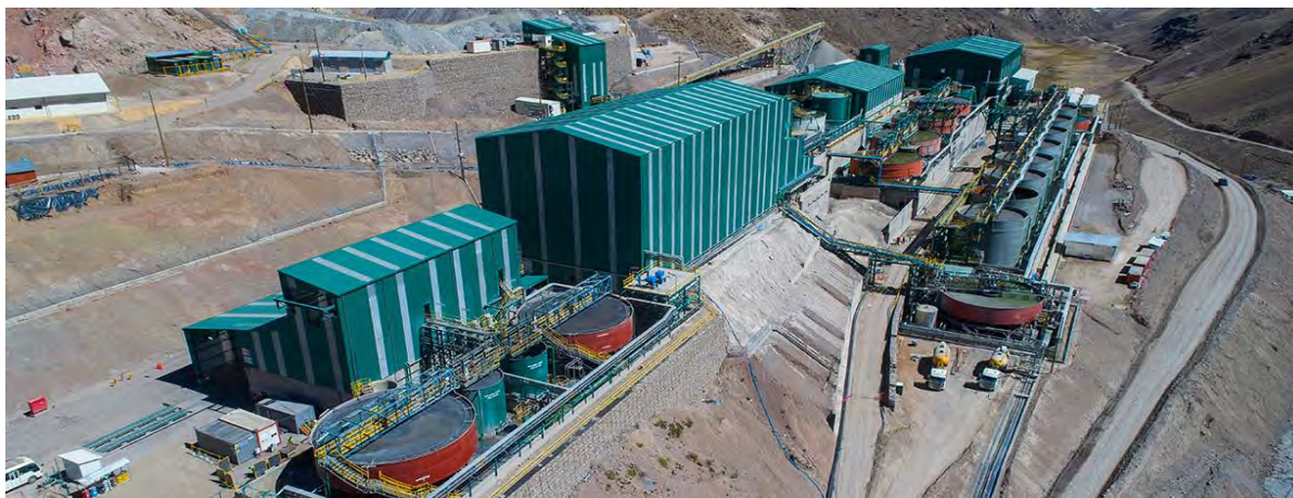
Figura 14. Construcción desarrollada por San Martín. Tomado de “Servicios y proyectos: Construcción,” por San Martín Contratistas Generales, 2019j ( http://sanmartin.com/servicios-y-proyectos/#construccion ).
