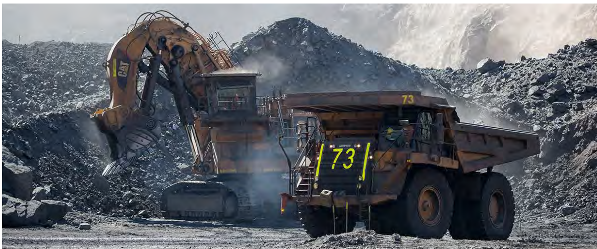
Figura 15. Operación minera desarrollada por San Martín. Tomado de “Servicios y proyectos: Construcción,” por San Martín Contratistas Generales, 2019; ( http://sanmartin.com/servicios-y-proyectos/#construccion ).
