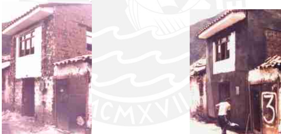
Figura 7.5 (a) Inicio del reforzamiento: retiro del tartajeo (b) Fin del reforzamiento: tarrajeo de las franjas (San Bartolomé 2002)
