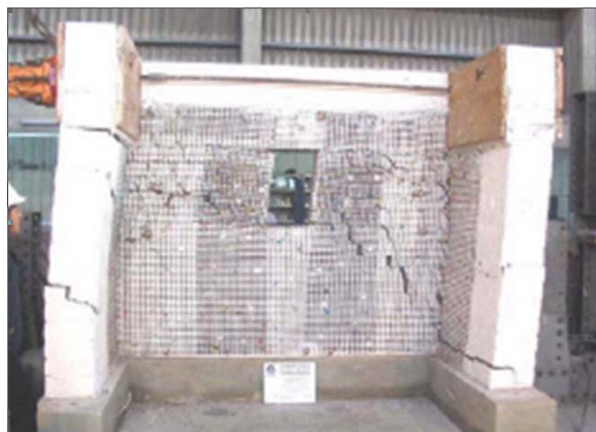
Figura 7.9 Muro reforzado con geomalla luego del ensayo sísmico (Madueño 2005)
