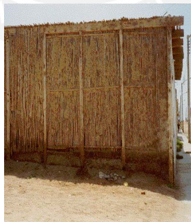
Figura 3.4 Muro de quincha
