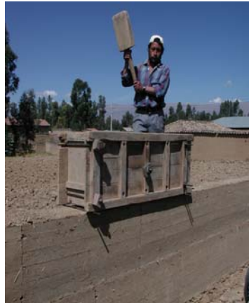
Figura 3.3 Muro de tapial
