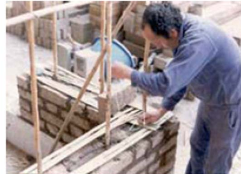
Figura 7.1 Refuerzo con cañas verticales (Vargas et al 1978)
