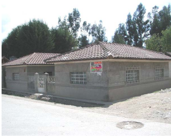
Figura3.12 Viviendas de tapial con planta en forma de C con patio exterior
