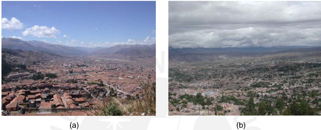
Figura 3.5 Panorámicas de (a) Cusco y (b) Ayacucho, Viviendas de adobe de dos pisos asentadas en laderas circundantes.
