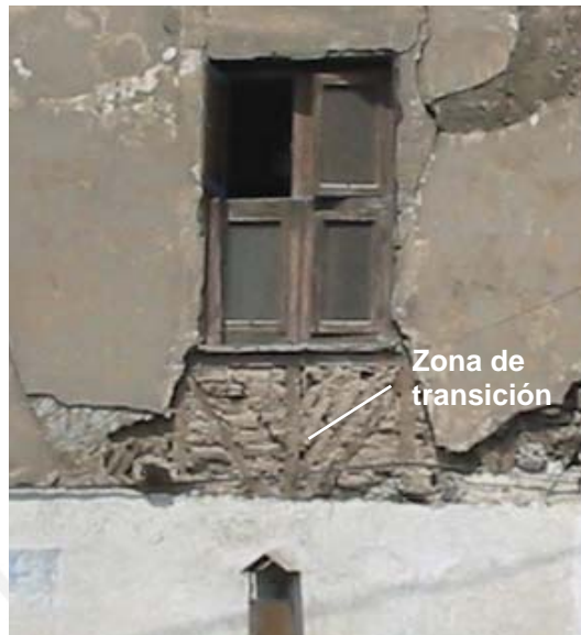
Figura 3.26 Zona de Transición entre muros de adobe y quincha
