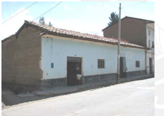
Figura 3.13 Vivienda de tapial con planta en forma de C con patio interior
