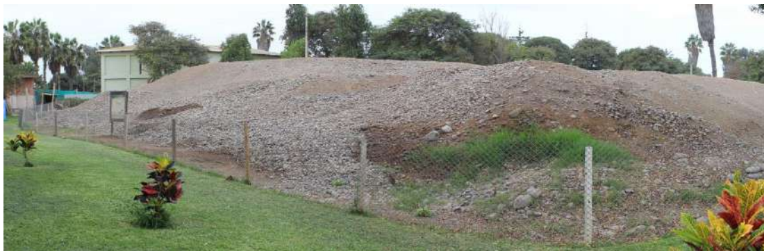
Figura 6. Esquina noroeste de la Huaca 33 en el año 2012 antes de la limpieza (Archivo fotográfico del PATPAL – FBB)
