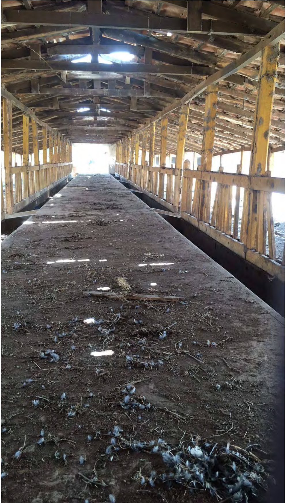
Interior del módulo lechero
