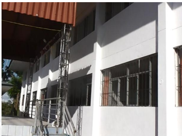
vista posterior del bloque 1 (aulas)
