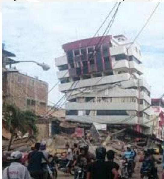
Figura 4.14 – Inclinación de entrepisos de la edificación [33]
