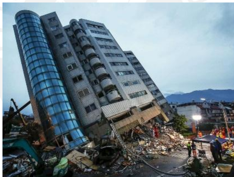
Figura 4.15 – Edificación fuera de su cimentación y colapsada [45]
