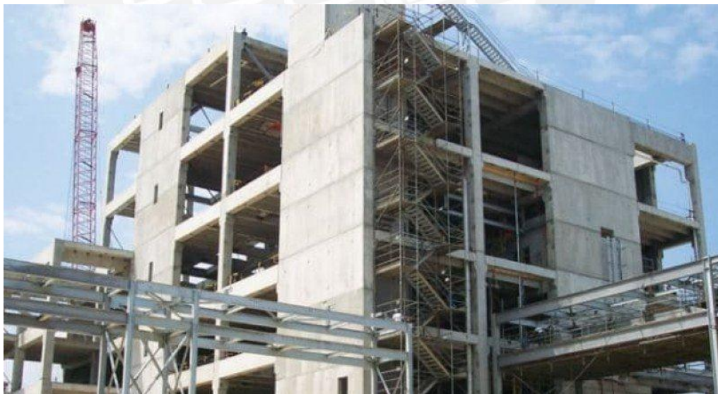
Figura 2.24 – Edificación con sistema dual [51]
