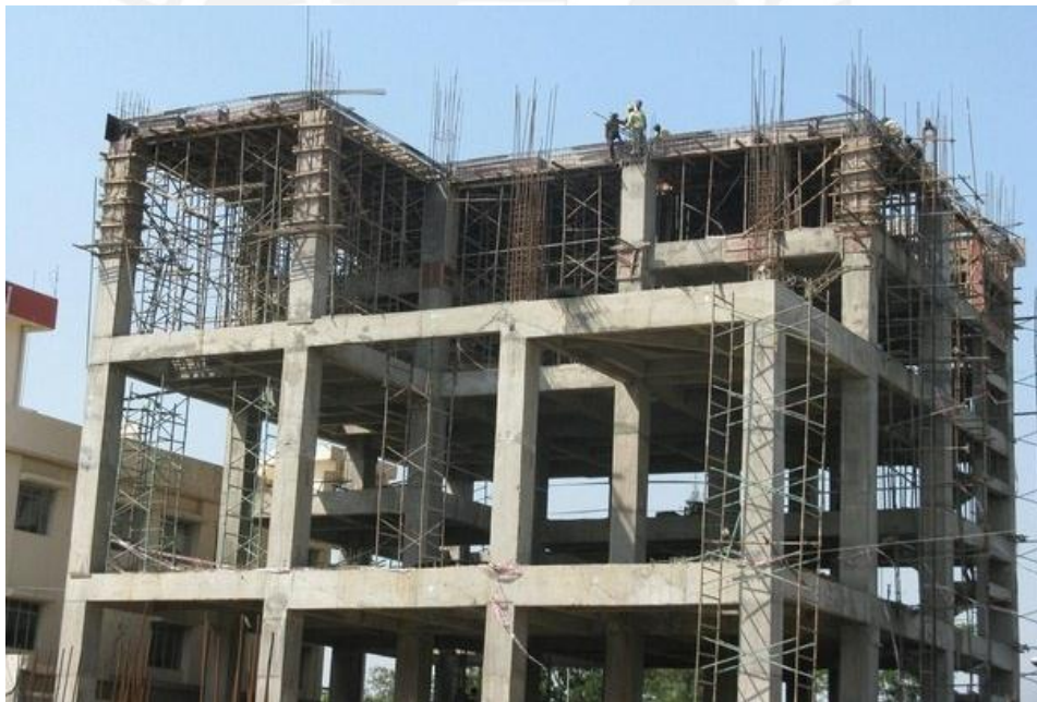
Figura 2.19 – Edificación con sistema estructural de pórticos [51].
