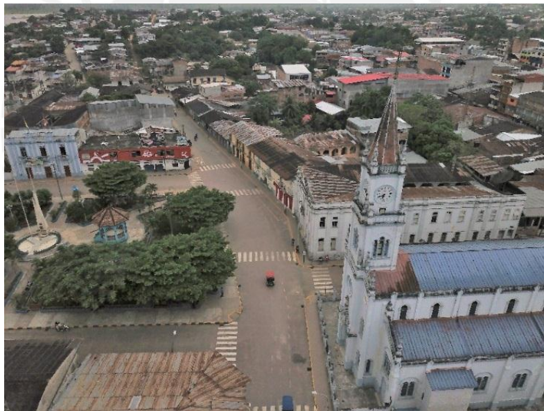
Figura 5.4 - Edificaciones en el radio urbano de Yurimaguas
