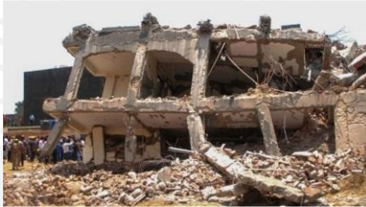
Figura 4.12 - Colapso total de elementos estructurales y no estructurales [21]
