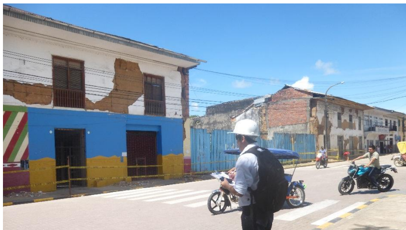
Evaluación del frente de la edificación
