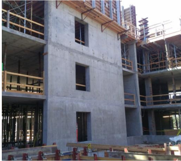
Figura 2.22 – Edificación con sistema de muros estructurales [52].
