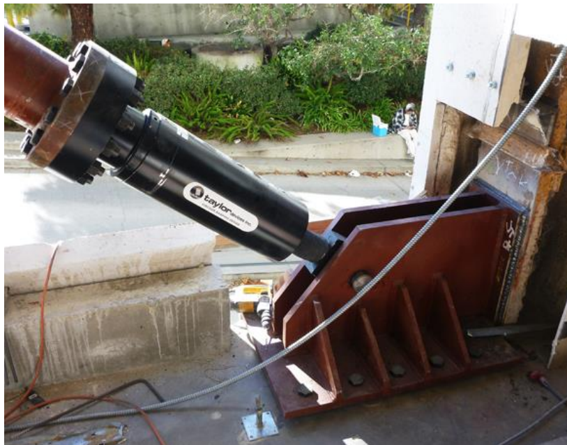
Figura 1.3 DFV montado en arriostre metálico [www.lfzgroup.com]
