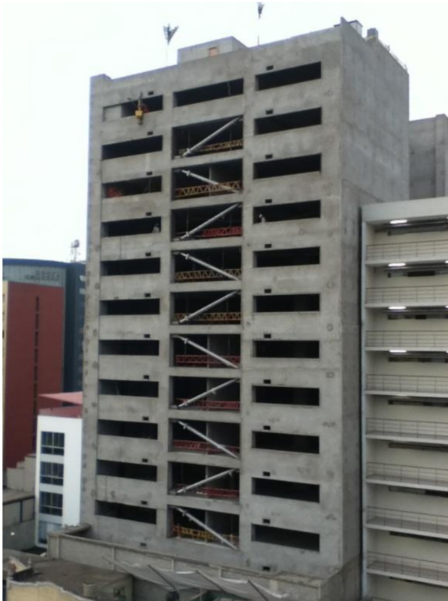
Figura 1.4 Edificio de oficinas Reducto de concreto armado con DFV (Lima, 2012)
