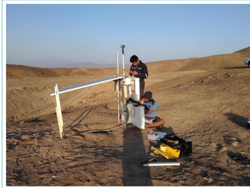
*Figura 10: Trabajos de Instalación del Magnetómetro de Pucusana, PM-12.*
