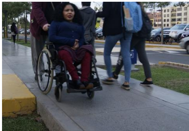
Cemento sin pulir con grava a la vista. Fuente propia.
