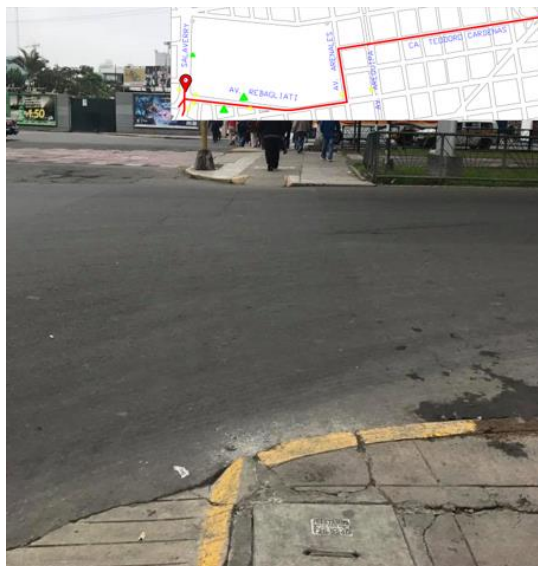
Figura 4.36 Inexistencia de señales horizontales. Fuente propia
