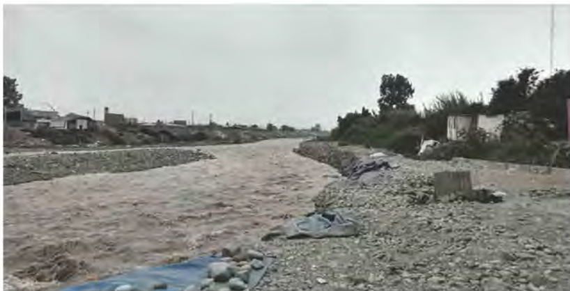
F. 16. Estado actual del río Chillón Fuente: Gonzales, M.J. (2018)
