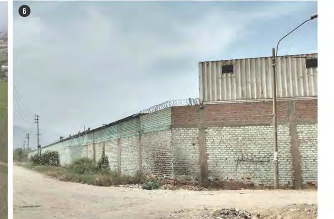
MUROS CIEGOS COMO CONSECUENCIA DE ALMACENES GENERAN DESCONEXIÓN Y ESPACIOS DESHABITADOS
