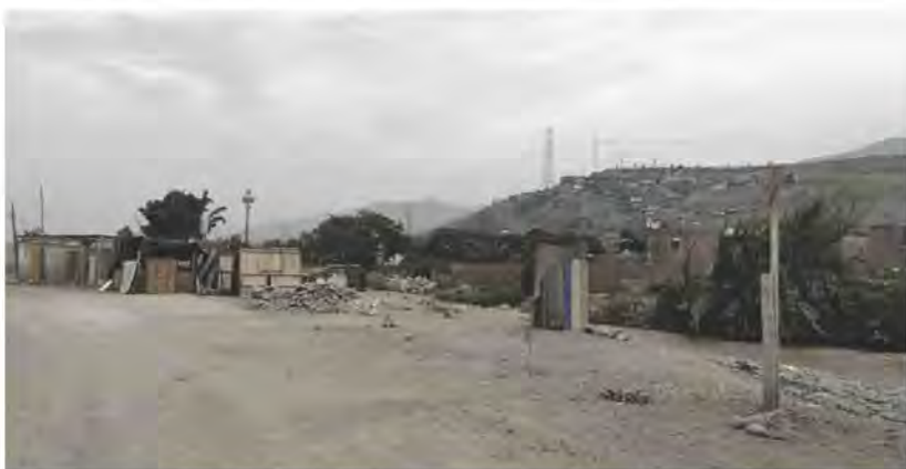
F. 17. Estado actual del borde del río Chillón (Comas) Fuente: Gonzales, M.J. (2018)
