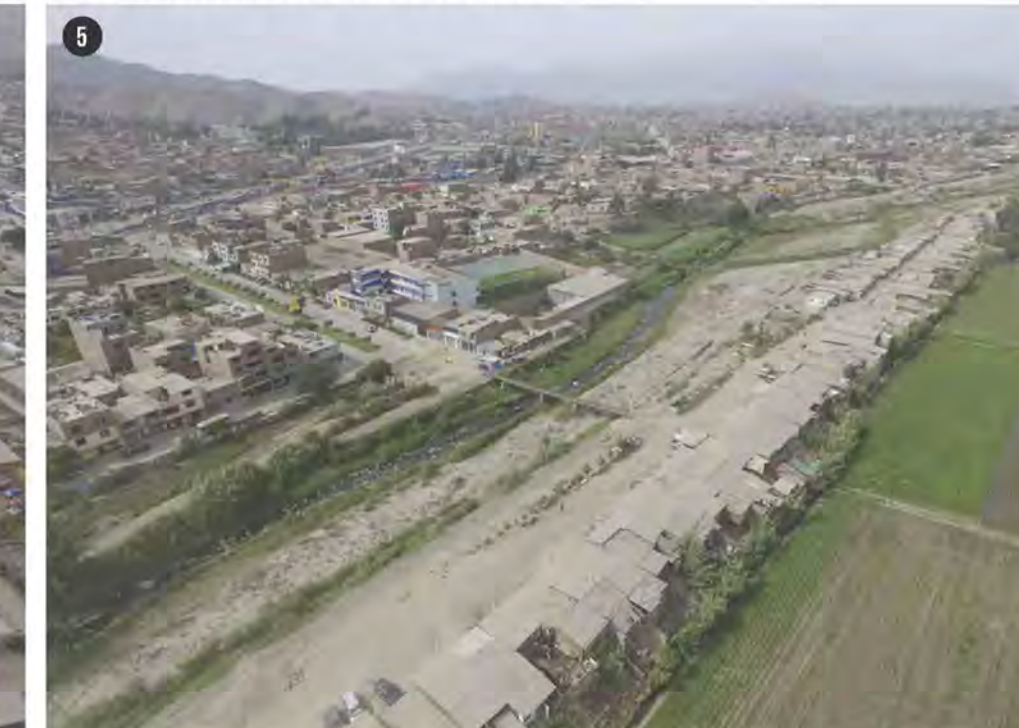
VIVIENDAS EN PELIGRO AL BORDE DEL RÍO
