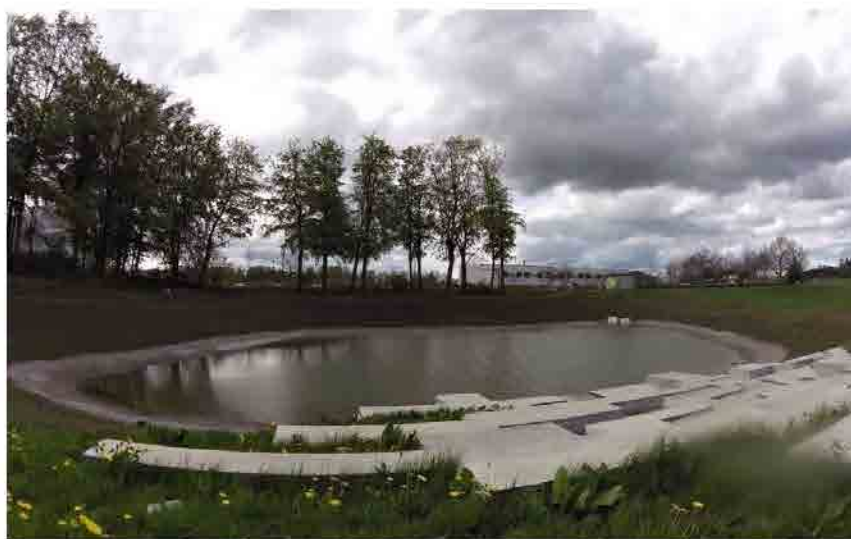
Infraestructura de mitigación : proceso de recolección de aguas pluviales
