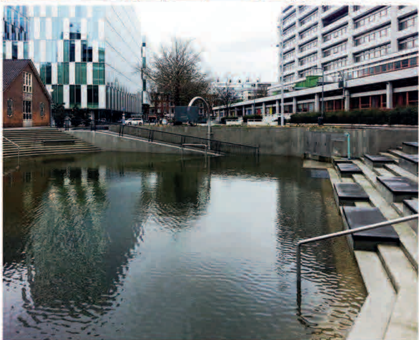
Infraestructura de recolección de agua pluvial durante temporada de precipitaciones
