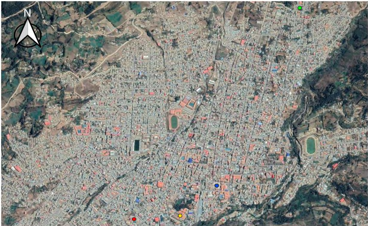
Figura 5.21. La ciudad de Abancay en el 2018 (con los mismos hitos señalados)
