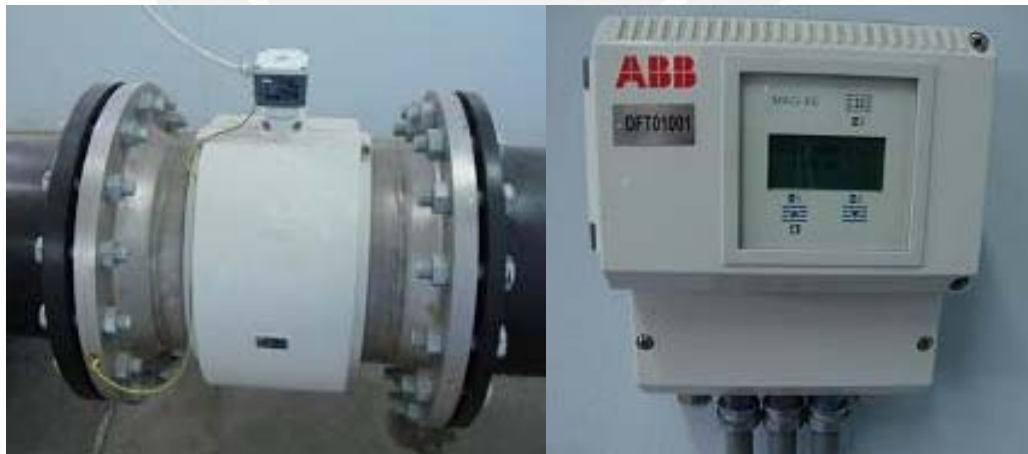
Figura 4.14: Sensor y Transmisor de Flujo
