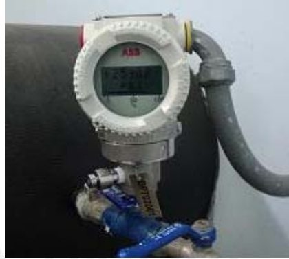
Figura 4.11: Transmisor de Presión, señal analógica de 4-20 mA.
