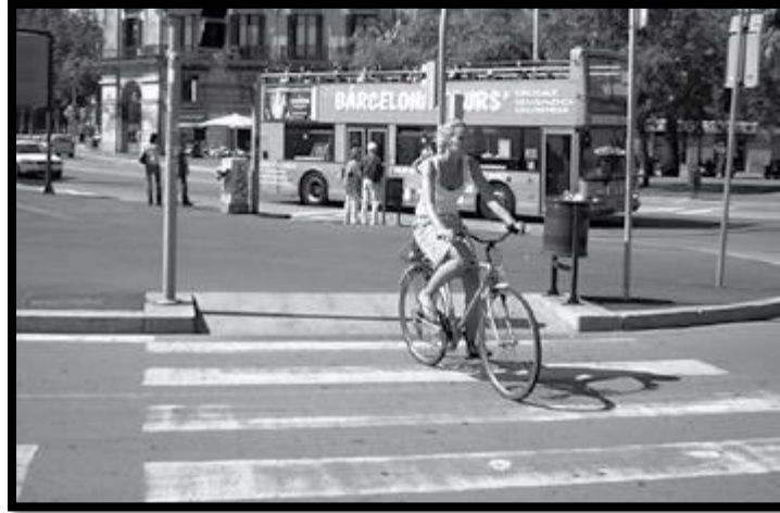
Figura 6: Rampa del mismo ancho que la vereda
