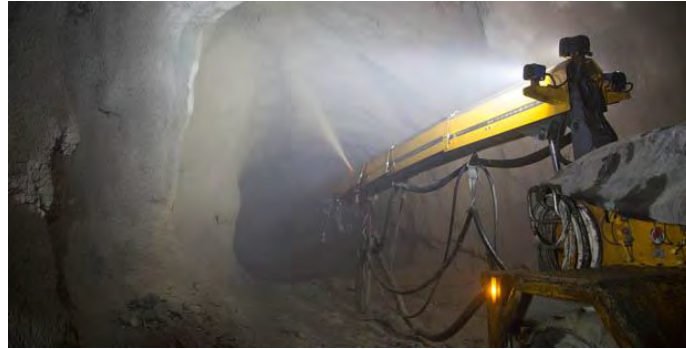
Figura.16 Concreto lanzado
