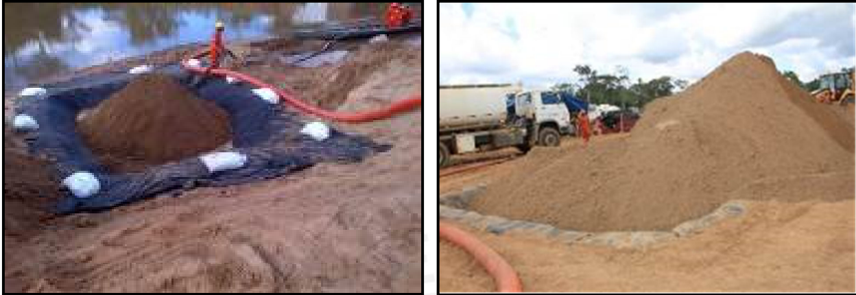
Foto N°18 Poza de prueba para el llenado de una Geoestructura Foto N°19 Poza de ejecución de obra para llenado de Geoestructuras
