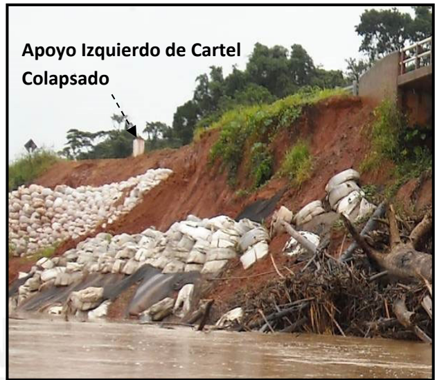
Fotos N°08 y 09 Proceso de socavación avanzado Margen Izquierdo Aguas Arriba (Enero 2010).
