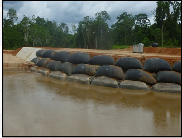
Foto N°15,16 y 17 Protección Ribereña con Sistema de Geoestructuras – Puente Mavila
