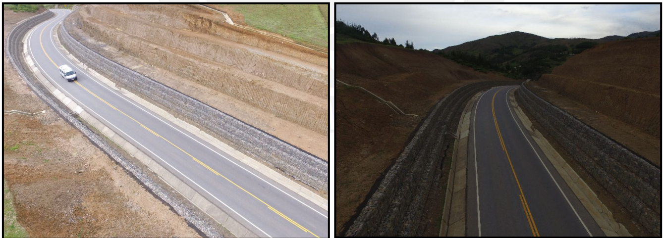
Foto N°13 y 14 Sistema de Contención de Taludes con Sistema de Gaviones Lado izquierdo y derecho de la vía
