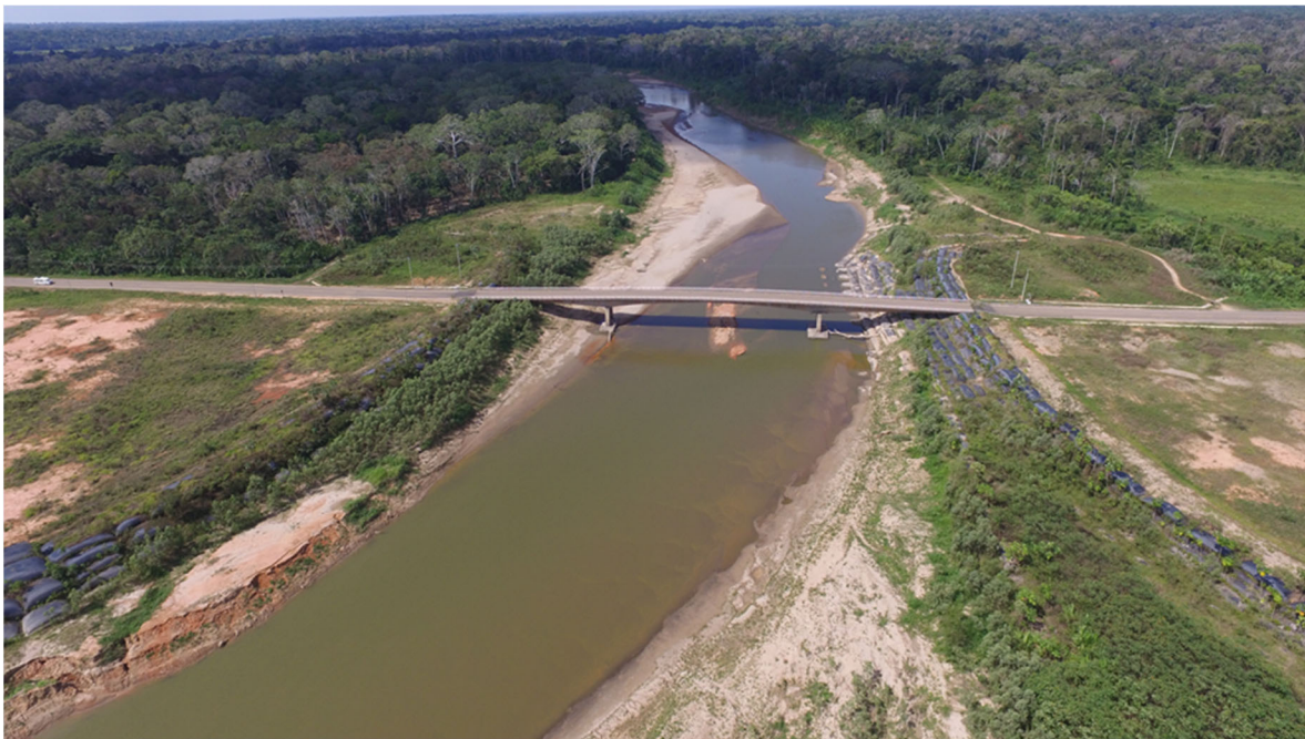
Foto N°20 Vista panorámica de los diques de protección, donde se muestra la armonía entre las geoestructuras y el entorno ecológico del sector.
