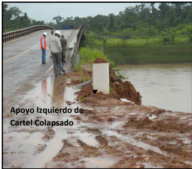
Fotos N°08 y 09 Proceso de socavación avanzado Margen Izquierdo Aguas Arriba (Enero 2010).
