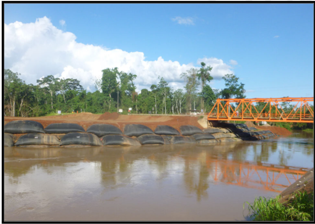
Foto N°15,16 y 17 Protección Ribereña con Sistema de Geoestructuras – Puente Mavila
