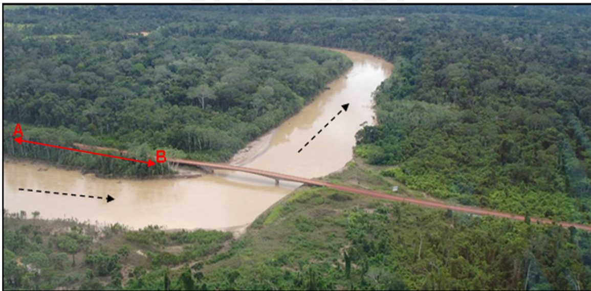
Foto N°01 Vista aérea del puente Tahuamanu (Enero 2009)
