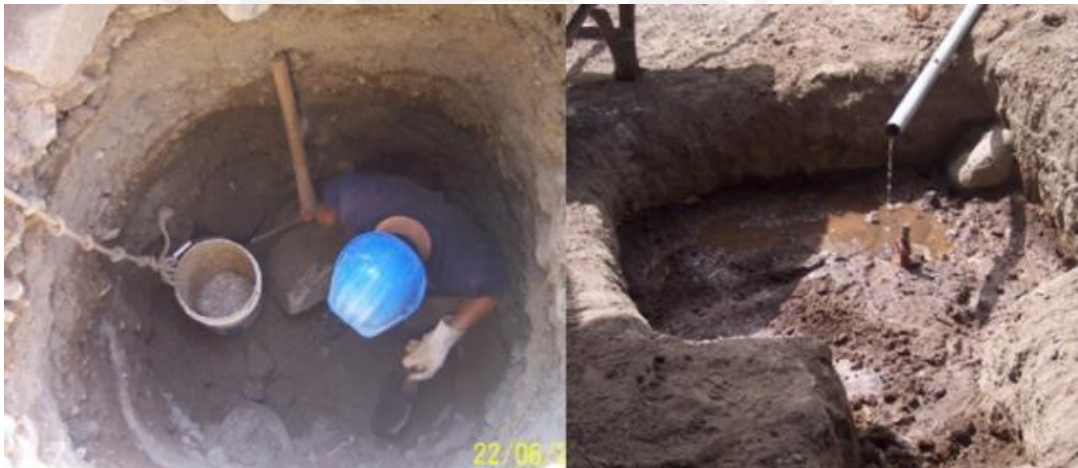
FIGURA 4 - 9: proceso de instalación del sistema de puesta a tierra
