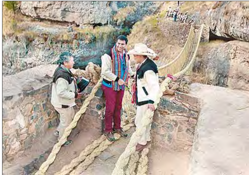
Figura 27. Gerente General de Banbif Juan Carlos García Vizcaíno entregando el donativo al alcalde Beltrán Huilca al finalizar la reconstrucción
