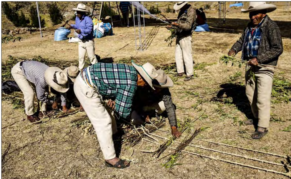
Figura 12. Comuneros de Chocayhua construyen el piso del puente
