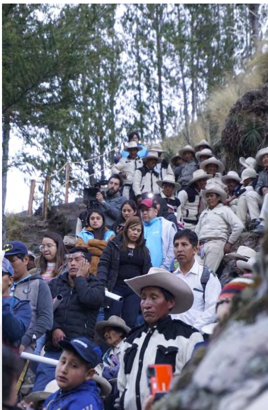
Figura 16. Una vez terminada la reconstrucción, todos los asistentes pueden bajar a la plataforma.
