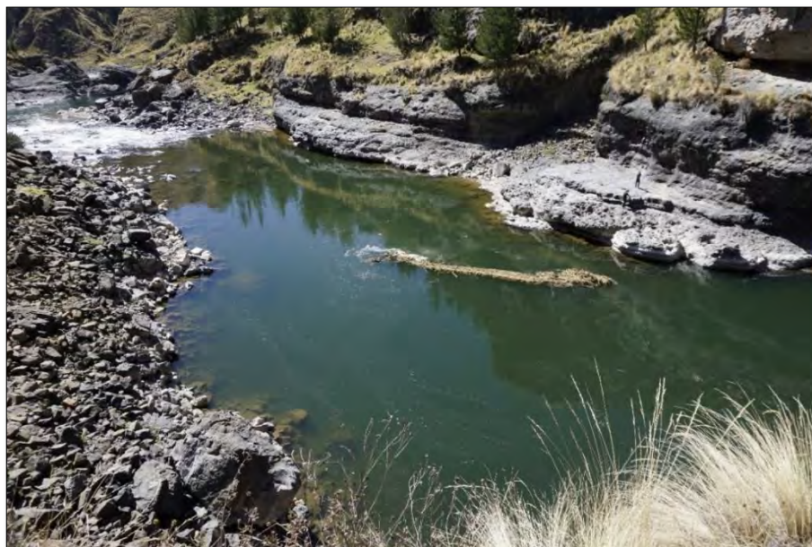
Figura 14. El puente viejo es cortado y dejado a la corriente del río Apurímac.
