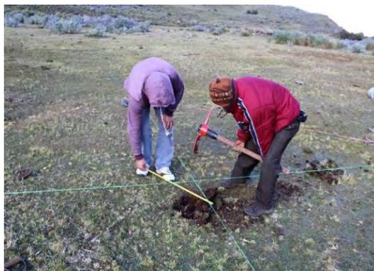
Imagen N° 1. Retiro de material orgánico y medición de la apertura realizada Fuente:
