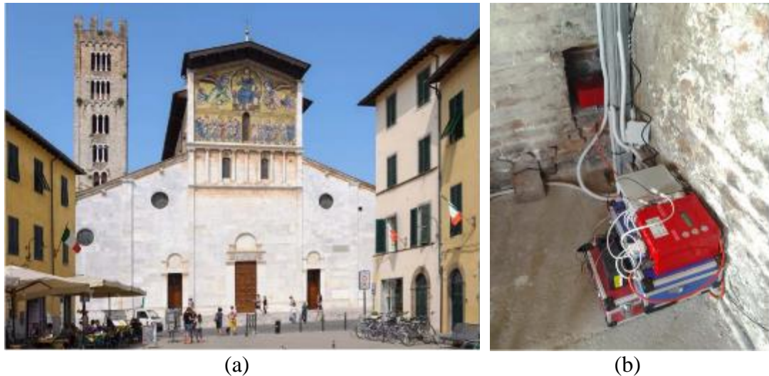
Figura 2.28: Detección de daño en el campanario de San Frediano: (a) La basílica de San Frediano y (b) estación de monitoreo sísmico (Azzara et al., 2018)
