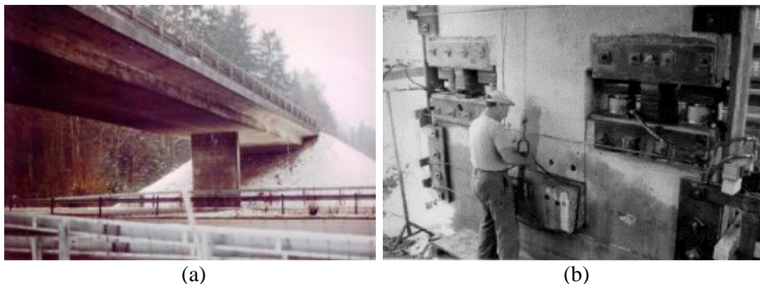
Figura 2.11: Identificación de daño en el puente Z24: (a) fotografía del puente y (b) aplicación de daño por asentamiento en una de las columnas (Maeck & De Roeck, 2003).
