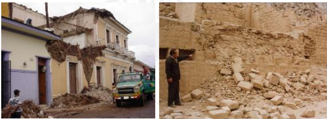
Figura 1.1: Daño en construcciones históricas por falta de mantenimiento oportuno: (a) daño por lluvias (Roblero, 2009) y (b) daño por movimientos sísmicos (Instituto Nacional de Cultura, 2007).
