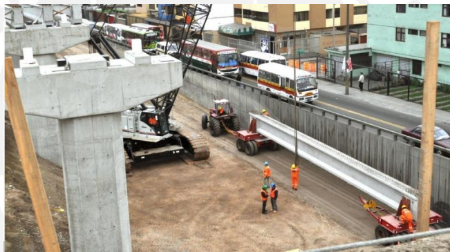
Figura 2.6: Uso de prefabricados en la Línea 1 del metro de Lima.
