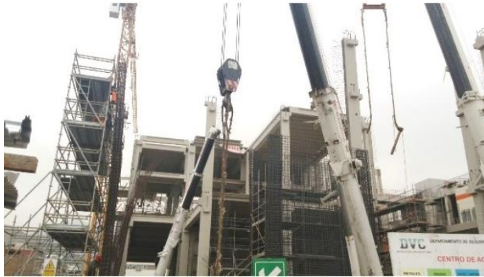
Figura 2.7: Construcción prefabricada Cinemark Megaplaza.
