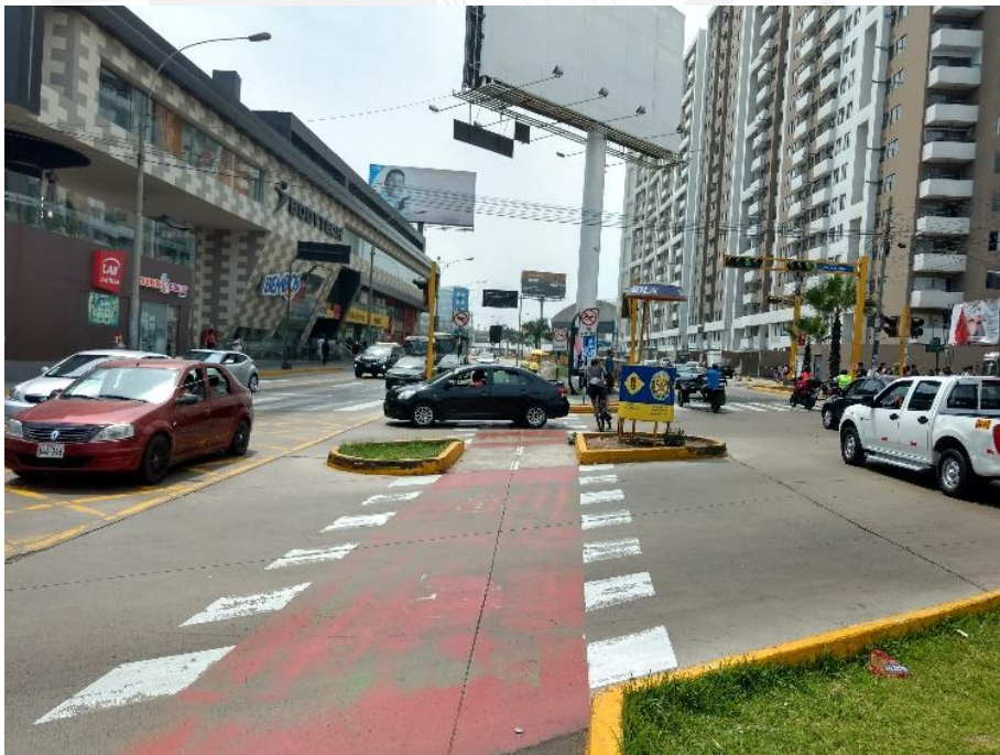
Figura 8. Isla refugio en la zona Central de la intersección.
