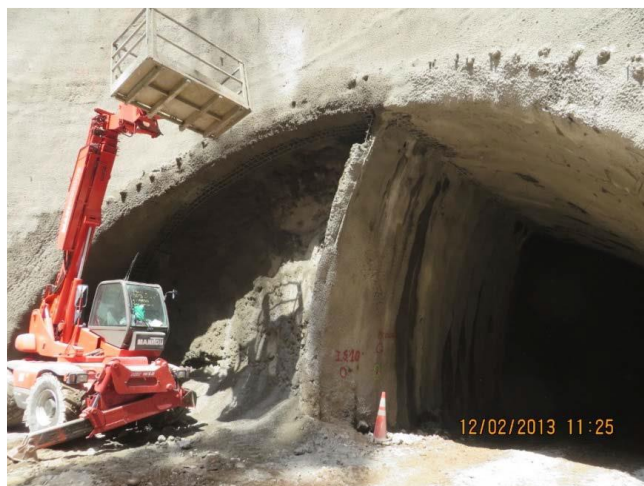
Fig. 45 - Excavación de la galería de conexión-Fase 2 (Constructivo 2013, ed. 34)
