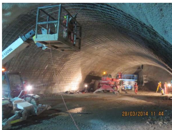
Fig. 24 - Armado de malla de acero (Velasco, 2014)
