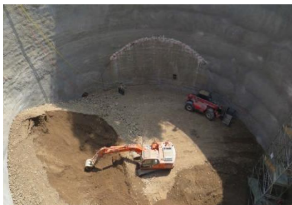
Fig. A4 - Bóveda o Pique Circular - Santiago de Chile, Línea 6 (Velasco T, 2015)
