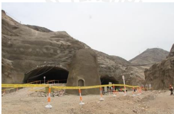
Fig. 3 – Reinicio de obras en el túnel Santa Rosa (Emape, 2011)
