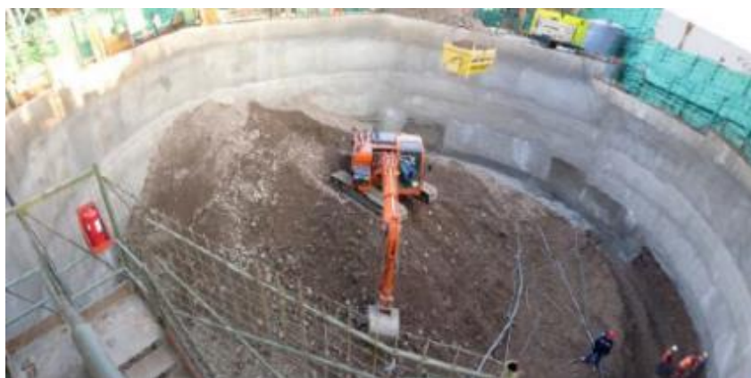
Fig. 56 - Bóveda de inicio – Estación Inés Suarez, Línea 6 Santiago (Velasco, 2013)
