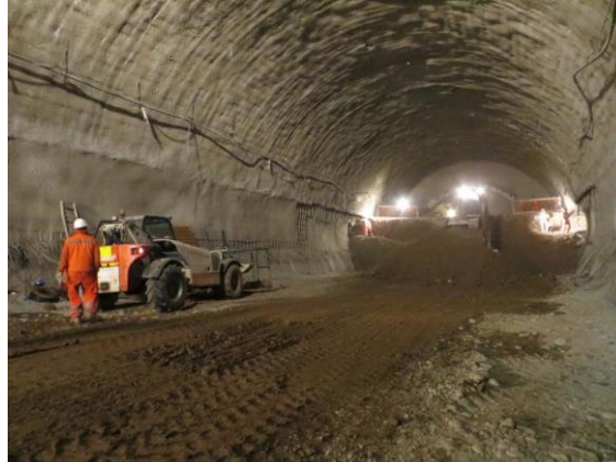
Fig. 25 - excavación del banco (Velasco, 2014)
