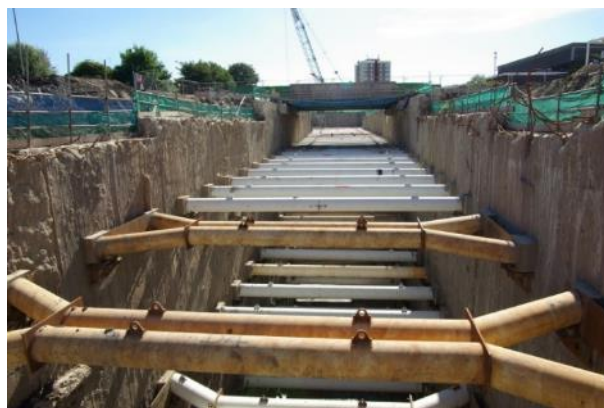
Fig. 29 - Entibado de los muros (Santoyo et all, 2011)
