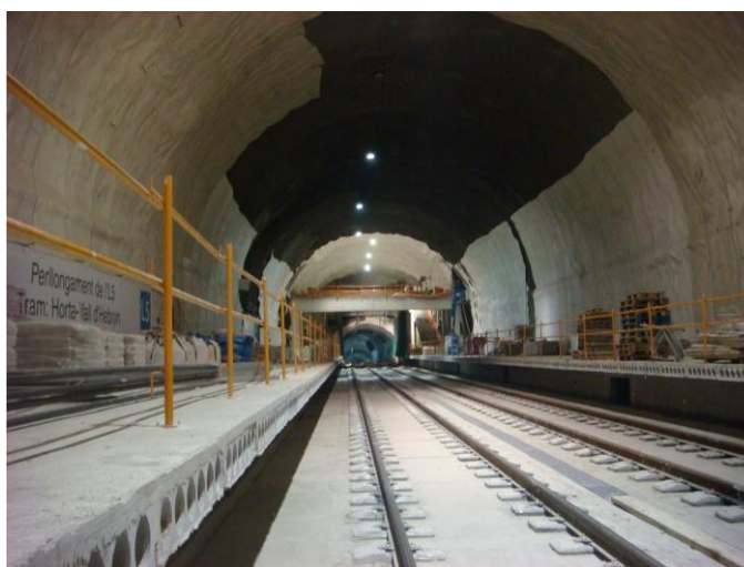
Fig. 49 - Tendido de rieles en túnel inter-estación - Fase 3 (Constructivo 2013, ed. 34)
