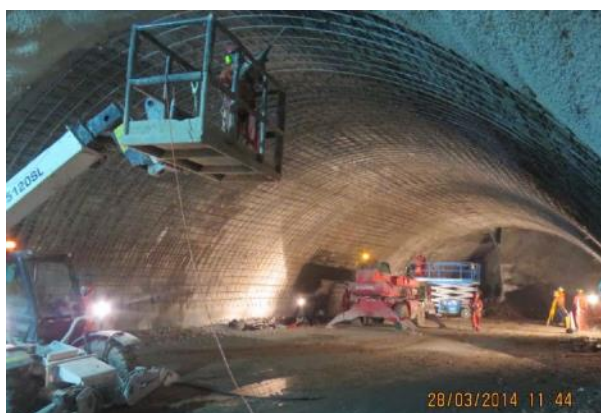
Fig. 57 - Enmallado previo a la segunda capa de hormigón (Velasco, 2013)
