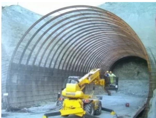
Fig. 13 - Cerchas metálicas para refuerzo (López, 2011)
