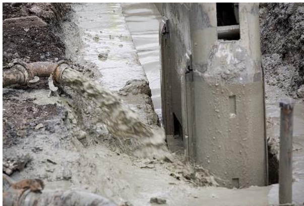
Fig. 32 - Estabilización con lodo bentónico (Terratest, 2013)
