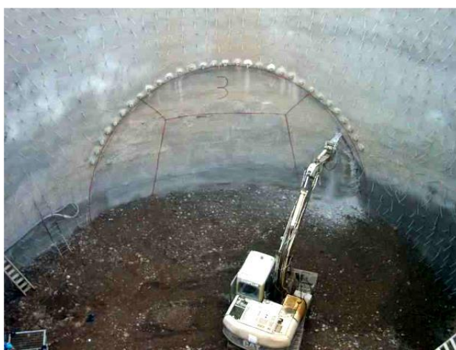
Fig. 11 - Micropilotaje en la sección de Corona (AATE, 2015)
