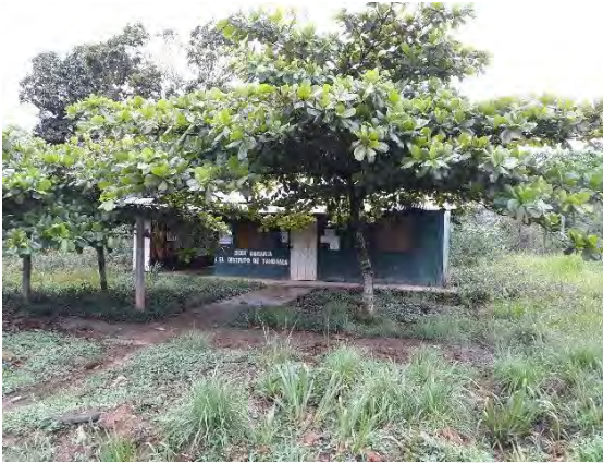
Foto N°37 y 38. Sede Agraria en el Distrito de Tahuania
