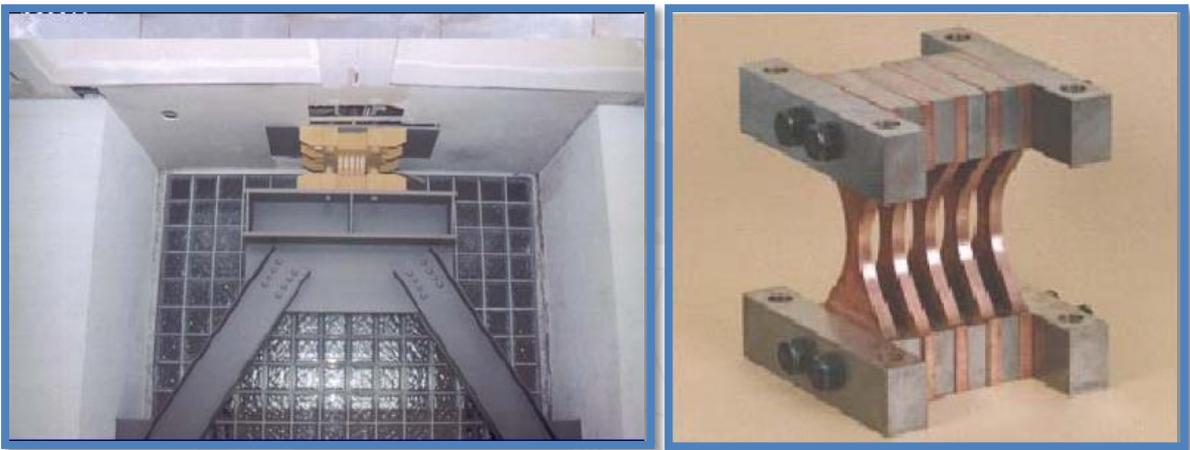
Fig. 5. Dispositivo de amortiguación por fluencia Metálica ADAS.
