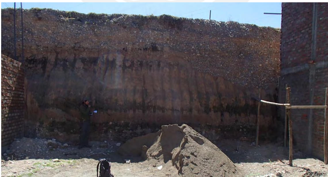
Figura 3-12 Gravas clasto-soportadas depositadas disconformemente sobre unidad lacustre
