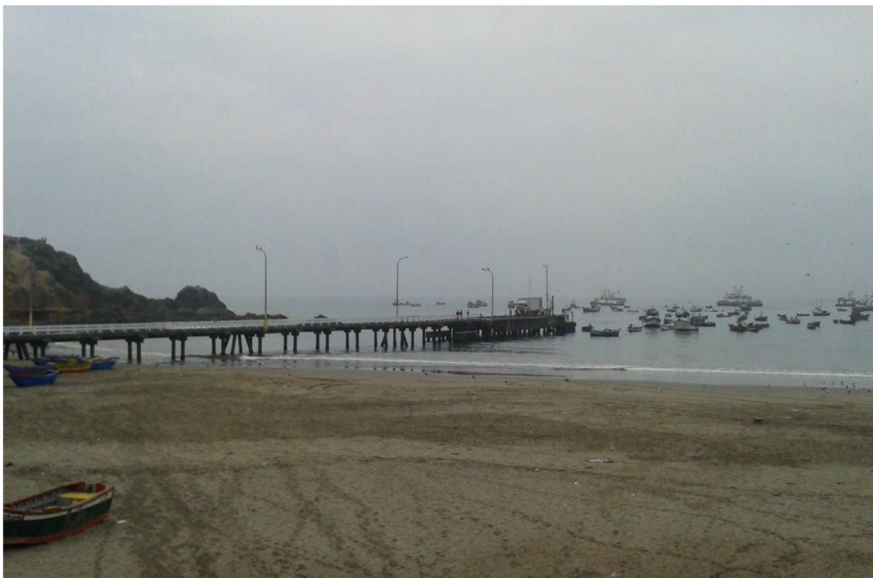
Figura 2. Situación actual del muelle conocido como “Pescadores”.
