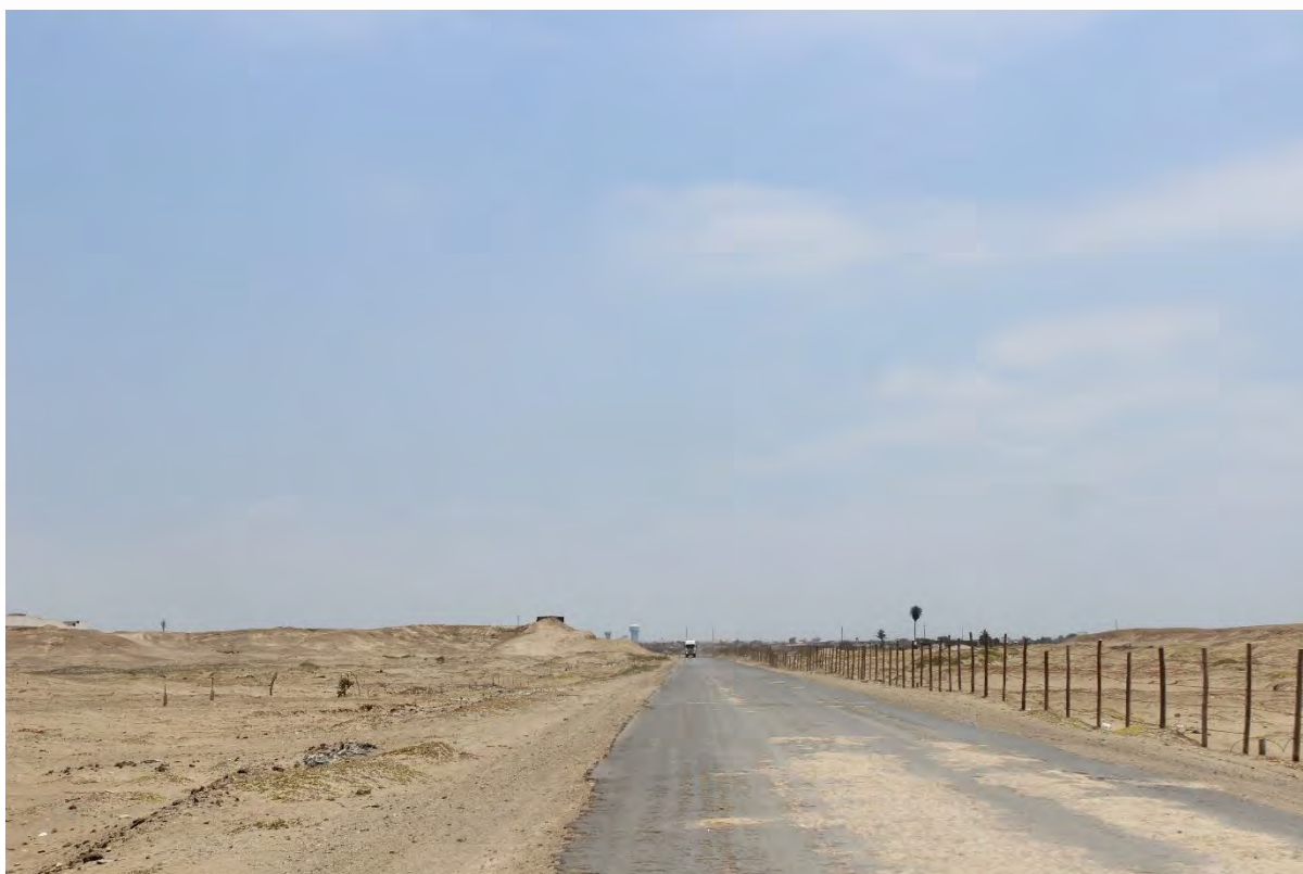
Figura A7. Estado de la vía entre Puerto Eten y PetroPerú. Las vías se encuentran en pésimas condiciones donde transitan carga pesada.
