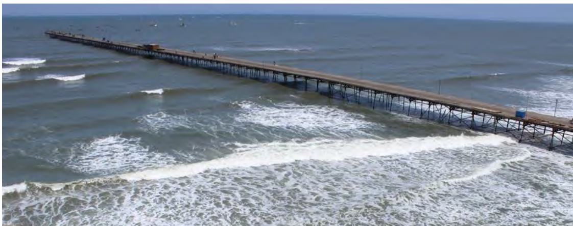
Figura 7. Situación actual del muelle de Puerto Eten.
