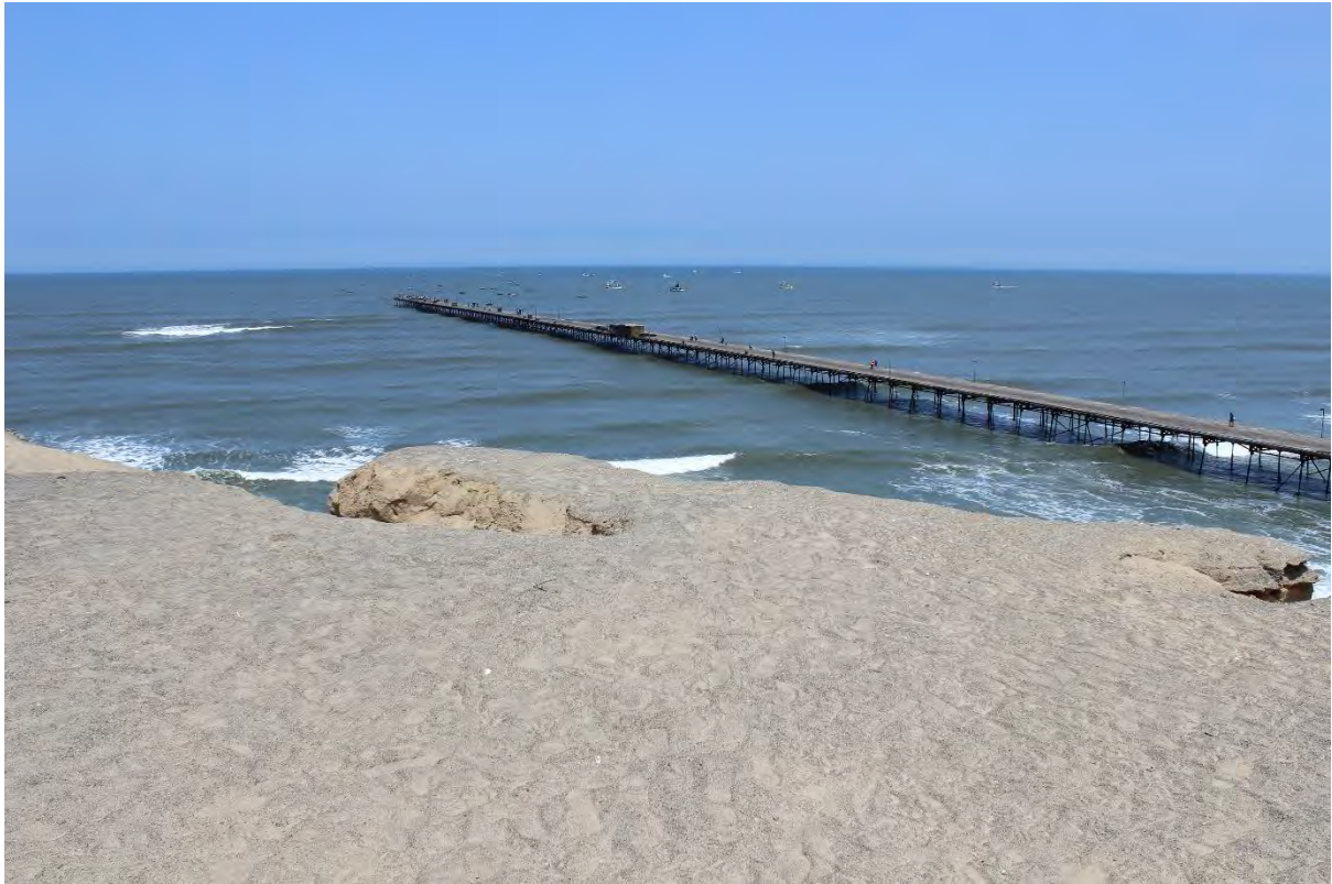
Figura A3. Actual muelle de Puerto Eten. El muelle en la actualidad se usa principalmente para la pesca artesanal.
