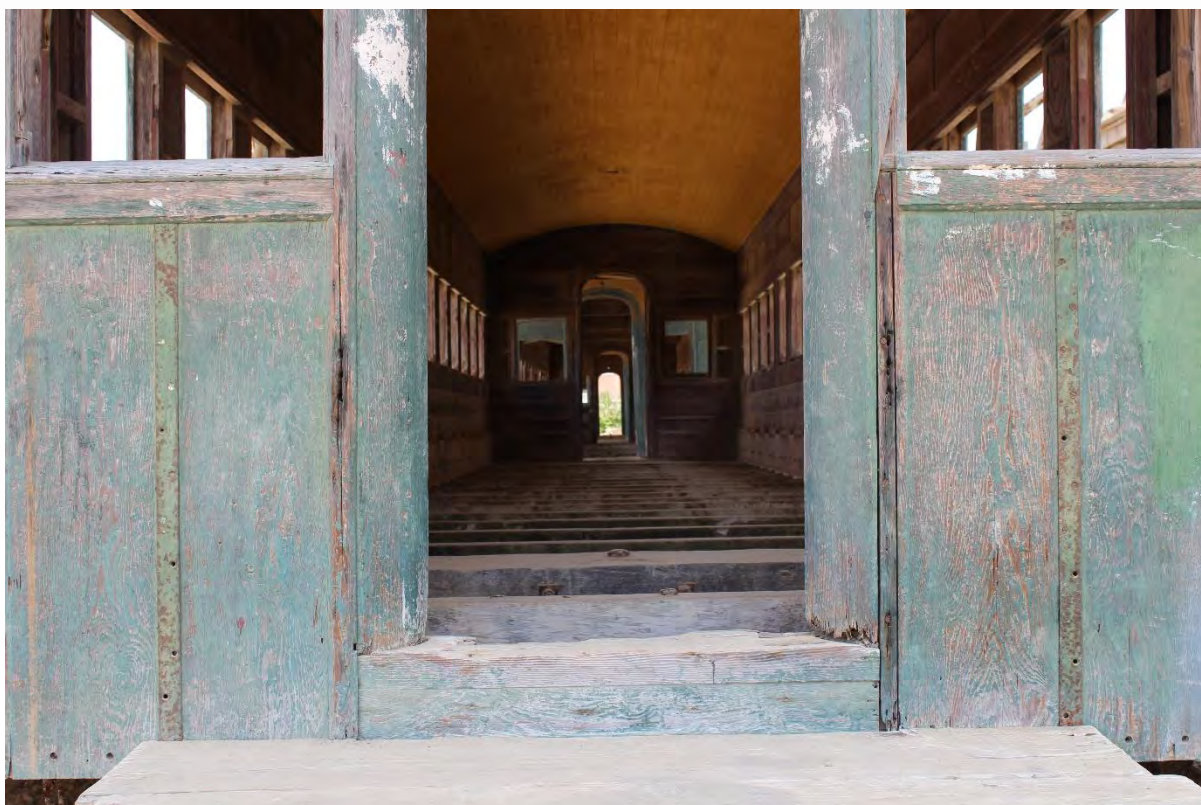
Figura A13. Interior de los vagones de la antigua ferrovía.
