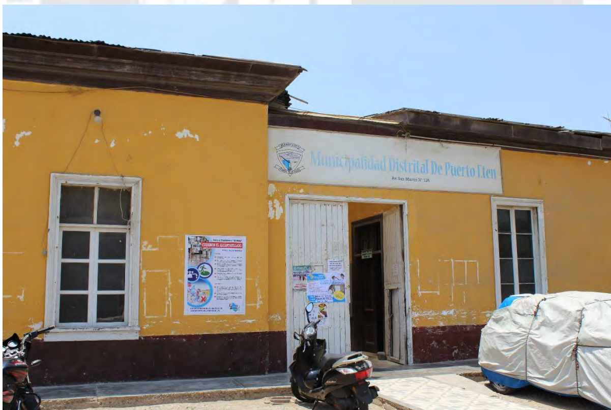
Figura A14. Fachada de la Municipalidad Distrital de Puerto Eten. Se aprecia a la institución en condiciones precarias.
