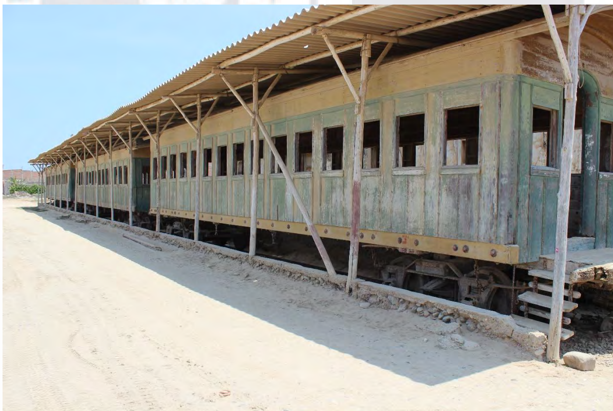
Figura A12. Restos de los vagones de la antigua ferrovía
