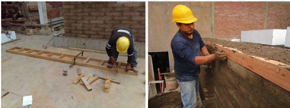
a. Construcción de la viga solera de madera tipo escalera b. Rellenado de los espacios vacíos en la viga de madera
