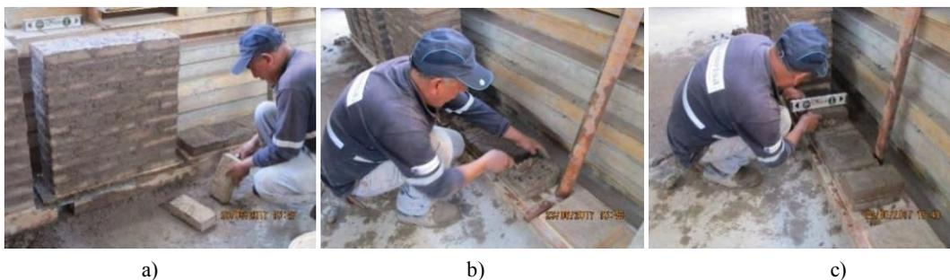
Figura 3.19. a) Primera hilada de adobes, b) Colocación del mortero y c) Verificación de verticalidad
