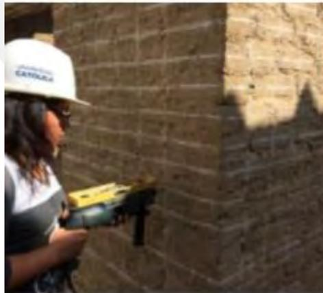
Figure 4.10. Perforación de la mampostería para insertar el refuerzo con sogas (Blondet, Villa Garcia, Vargas, Sosa, & Soto, 2017)
