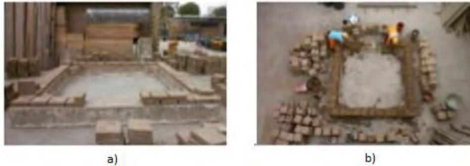
Figure 4.6. (a) Emplantillado sobre cimentación. (b) Primera hilada sobre base de mortero. (Blondet, Villa Garcia, Vargas, Sosa, & Soto, 2017)
