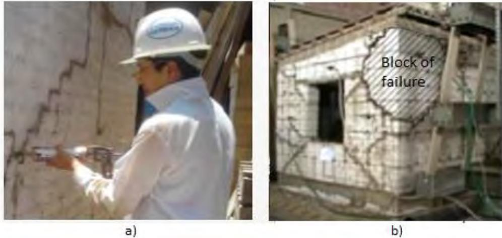
Figura 2.17 (a) Reparación del módulo mediante inyección de barro. (b) Bloque de falla sostenido por sogas en el módulo de adobe dañado. (Sosa & Soto, 2014).
