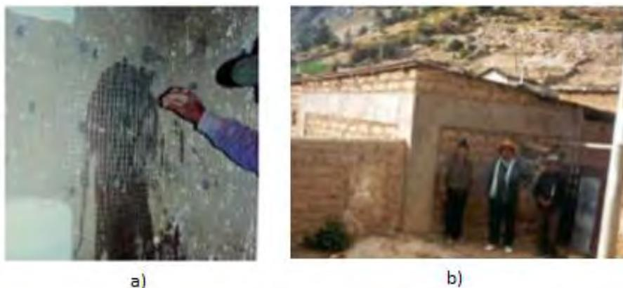
Figura 2.20 (a) Colocación de malla de alambre electro soldada en el muro. (b) Vivienda de mampostería de adobe reforzada con malla electro soldada. (Zegarra, San Bartolome, & Quiun, 2004)
