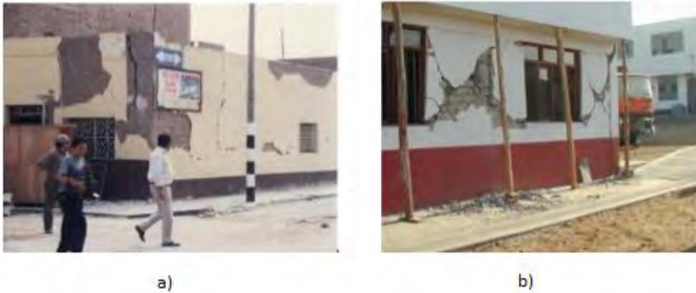
Figura 2.6 (a) Grietas verticales en la esquina del muro de fachada. (b) Grietas diagonales entre ventanas. (Zegarra, San Bartolomé, & Quiun, 2004) (Aguilar & Blondet, 2007)
