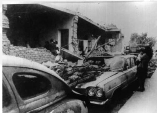
Figura 2.5 Colapso de una vivienda de adobe en Chimbote, Perú debido al terremoto de 1970 (Quiun, San Bartolomé, & Zegarra, 1996).
