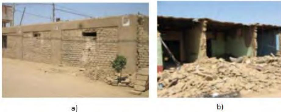
Figura 2.23 (a) Viviendas de mampostería de adobe con refuerzo con malla electro soldada luego del terremoto de Ica 2007. (b) Viviendas de mampostería de adobe sin refuerzo colapsadas luego del terremoto de Ica del 2007. (San Bartolomé & Quiun, 2010)
