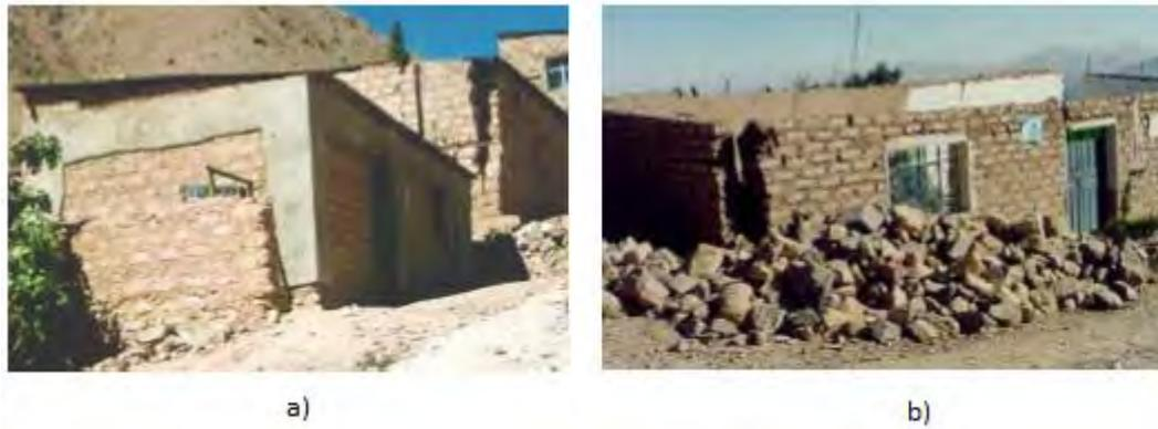
Figura 2.22 (a) Vivienda de adobe reforzada con malla electro soldada luego del terremoto de Tacna del 2001. (b) Vivienda de adobe luego del terremoto de Tacna del 2001. (Zegarra, San Bartolomé, & Quiun, 2004)
