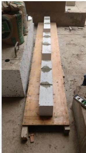
Figura 3.7 Colocación de ladrillos maestros en los 3 muretes
