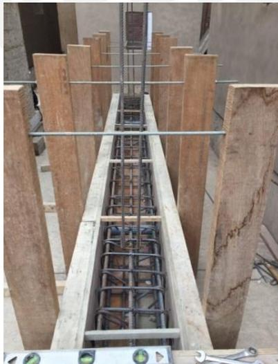
Figura 4.3 Armado de viga de cimentación
