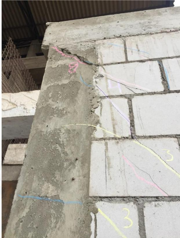
*Figura 6.14. Fisura marcada en columna de confinamiento*
