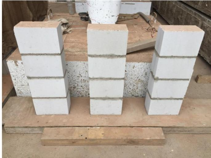
*Figura 3.2 Construcción de pilas*
