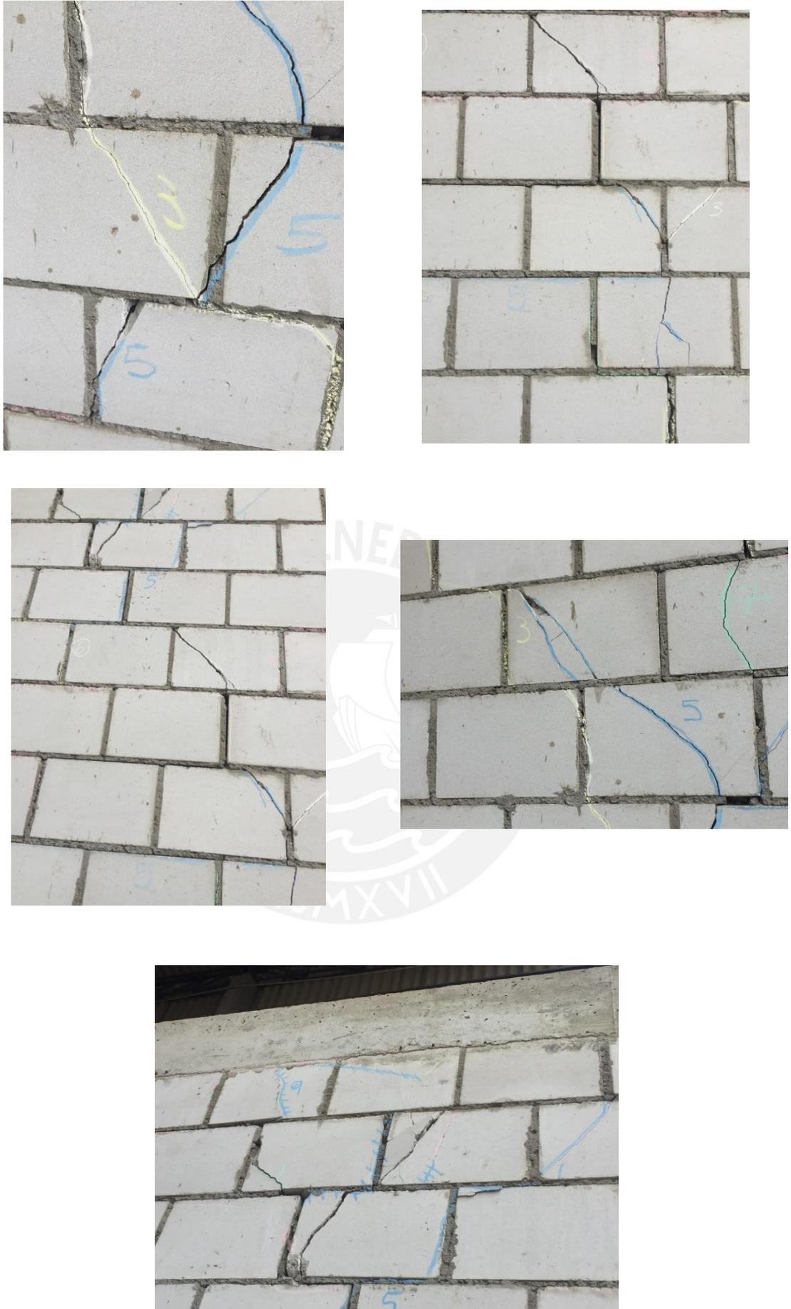
Figura 6.15. Fisuras en muro y trituración parcial de unidades
