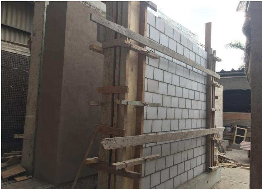
Figura 4.12 Encofrado de columnetas
