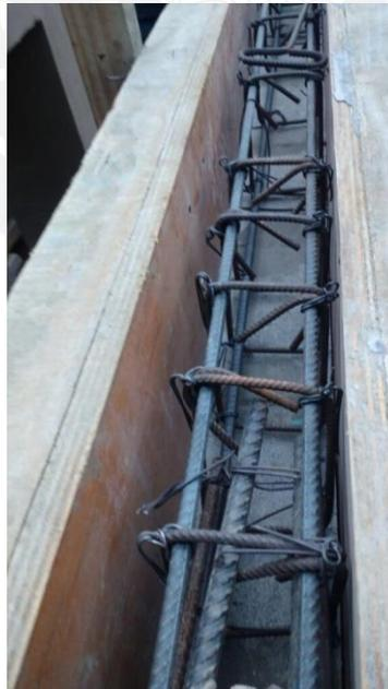
Figura 4.14. Colocación de Refuerzo en viga solera
