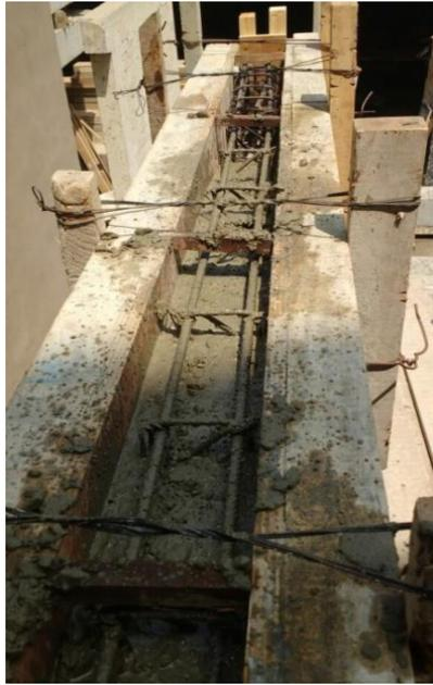
Figura 4.15. Vaciado de viga solera
