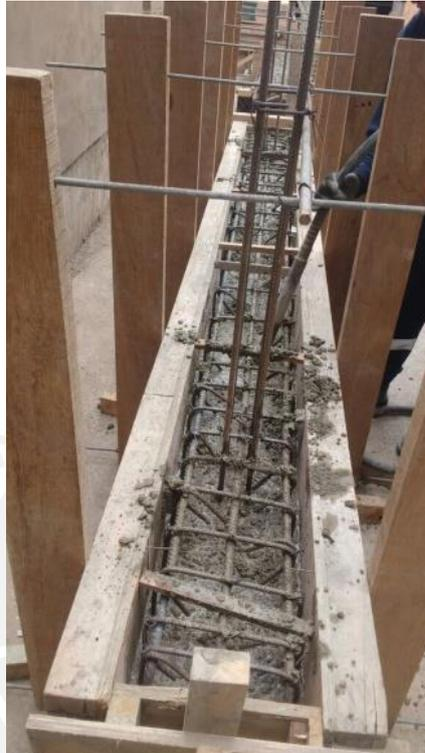
*Figura 4.4 Vaciado de viga de cimentación*
