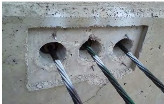
Figura 42. Marcado de cables postensado para verificar elongación (Fuente propia).
