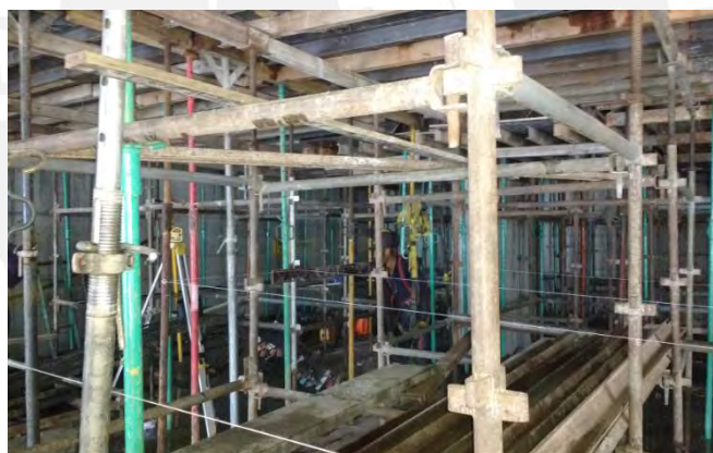
Figura 45. Proceso de control de deflexiones en etapa previa al tensado (Fuente propia).
