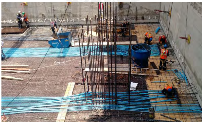
Figura 28. Encofrado horizontal techo Sótano 4 - Sector A (Fuente propia).
