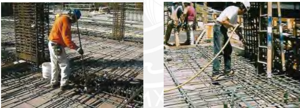
Figura 39.- Imágenes del proceso de limpieza de losas (Fuente Aalami, 2016)
