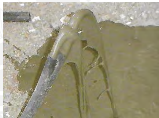
(b) Salida de lechada en despiche de la línea
