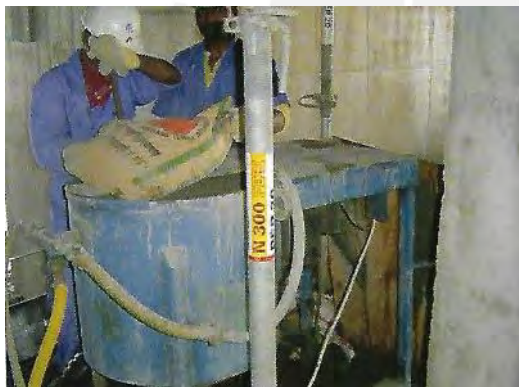
(a) Proceso de inyección de lechada.
