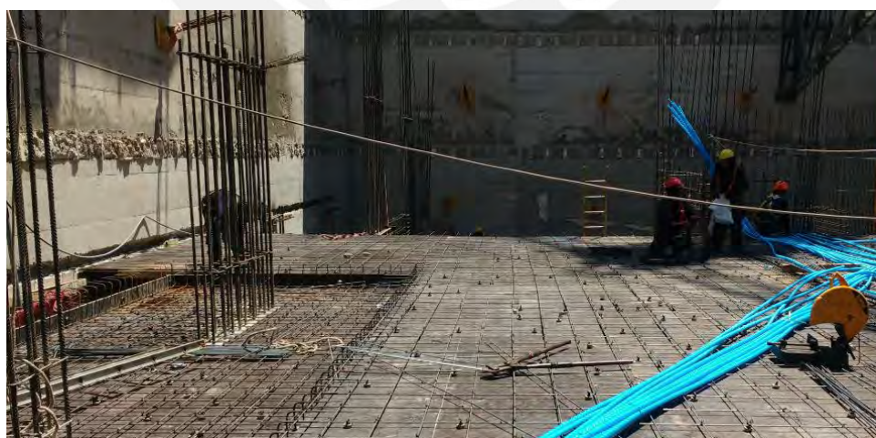
Figura 35. Colocación de malla de acero de refuerzo (Fuente propia).
