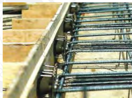
(b) Fila de anclajes asegurado.
