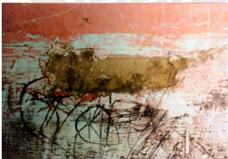
Detalle muro, hacienda Montalván, Cañete 1999
