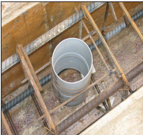
Foto 2.1. Colocación del suple en la viga de cimentación del muro M2.
