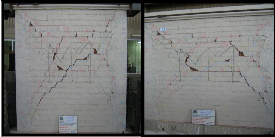
Foto 7.10. Muro M1 durante el ensayo armónico
