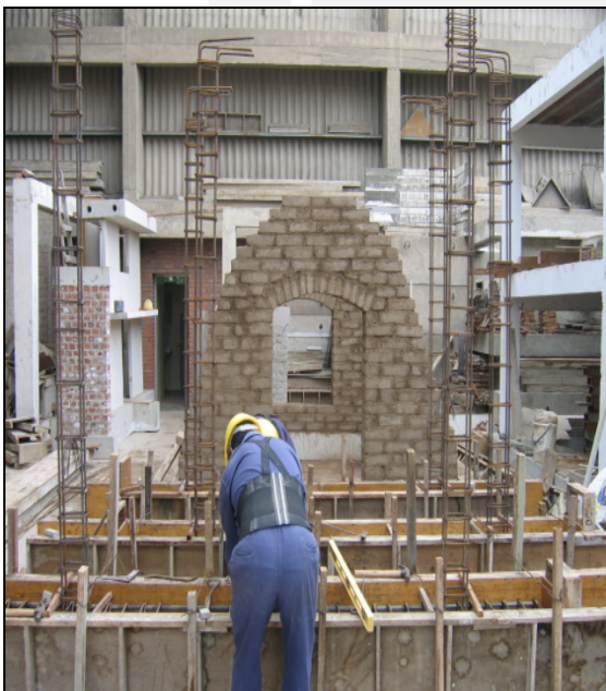
Foto 6.1. Encofrado de cimentación y colocación de refuerzo de columnas.
