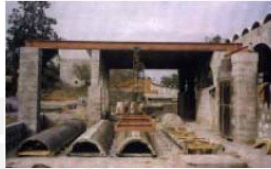
Elementos prefabricados de FERROCEMENTO en la India ( 2.5 cm de espesor, 6 m de largo)
