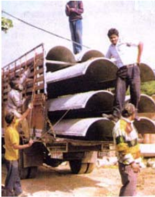
Elementos prefabricados de FERROCEMENTO en la India ( 2.5 cm de espesor, 6 m de largo)
