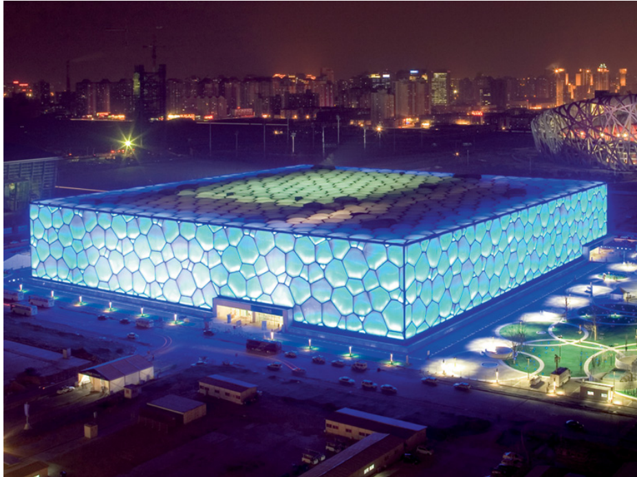
Figura 10 Watercube de Pekín, ejemplo de tensoestructura neumática de ETFE
