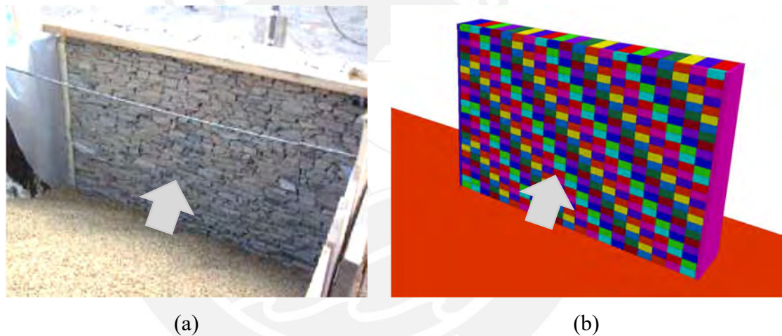
Figura 5.17: (a) Proceso de carga del DSRW con relleno granular [22] y (b) modelo numérico del muro antes de la aplicación del empuje
