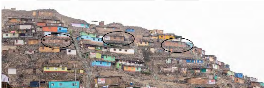
Figura 4.3: Viviendas de madera y de mampostería (señalado) en un sector de la quebrada El Progreso
