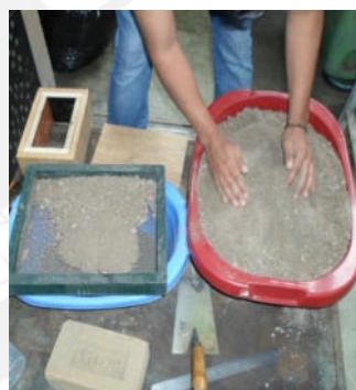
Figura 26. Preparación de la tierra
