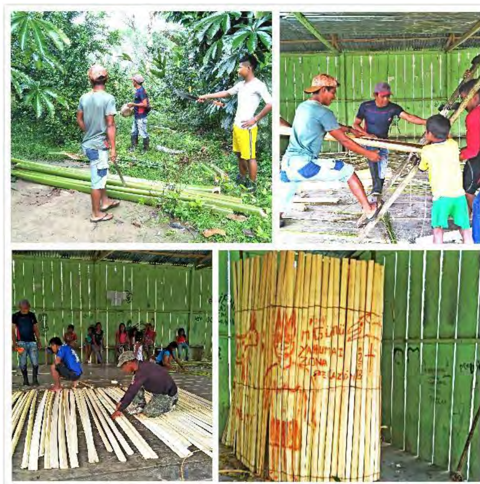
Ilustración 3. Construcción de la reclusión de la worecú situada en un rincón de maloca colectiva durante la pelazón (Yahuma Primera Zona)
