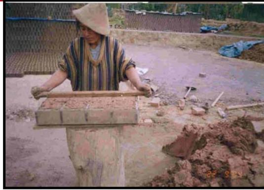
**Figura N° 2.10.** Nivelado y Separado del excedente de barro con una regla
