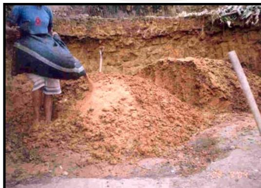
Figura N° 2.5. Agregado de aserrín a la mezcla de barro.
