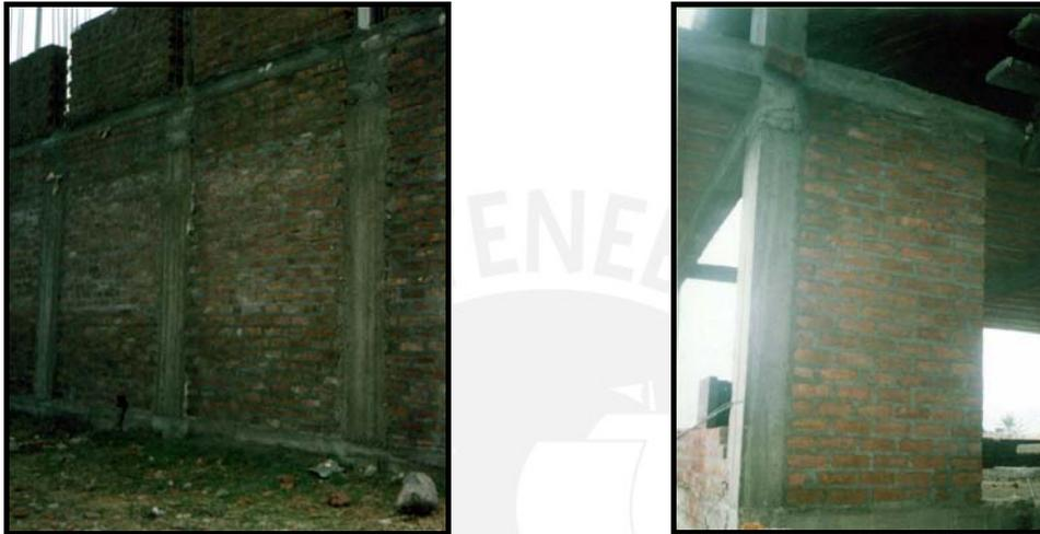
**Figura N° 4.11.** Muro confinado en sus cuatro bordes y muro confinado sólo en tres bordes.
