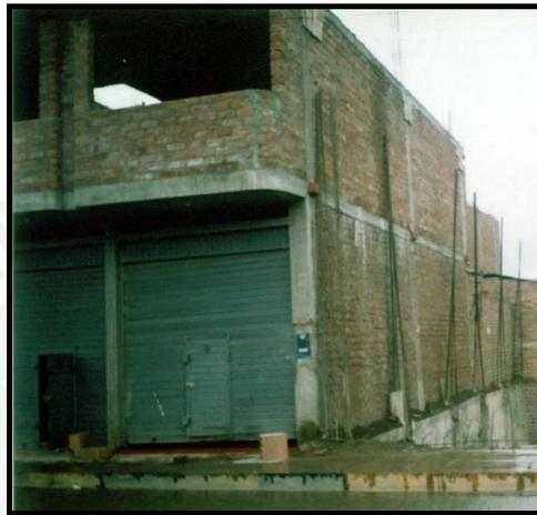
**Figura N° 4.7** Vivienda de dos niveles, con muros de cabeza en el primer nivel y soga en el segundo, altura promedio  $h = 2.40\text{m}$ .
