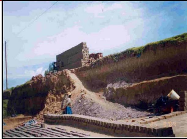
**Figura N° 2.3.** Taludes generados por la extracción de la materia prima para la elaboración de las unidades de albañilería
