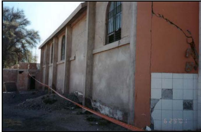
**Figura N° 1.2.** Fisuras y falla por corte en muros de Iglesia (Arequipa-2001)
