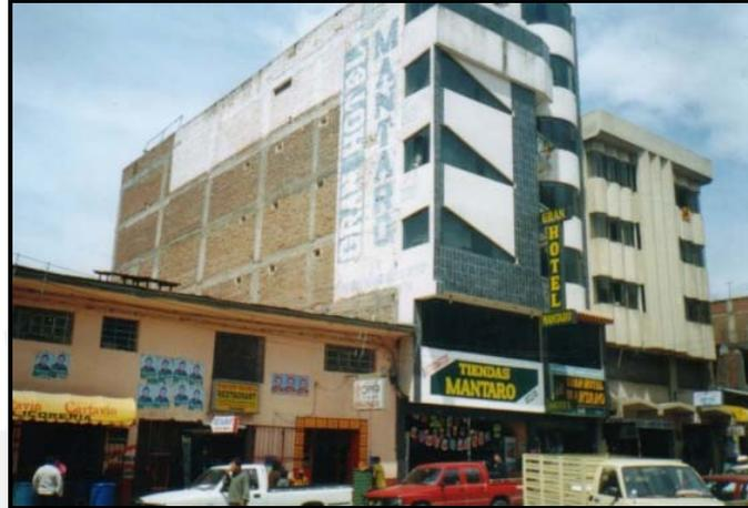
**Figura N° 4.28** Edificio de 6 niveles de albañilería confinada.
