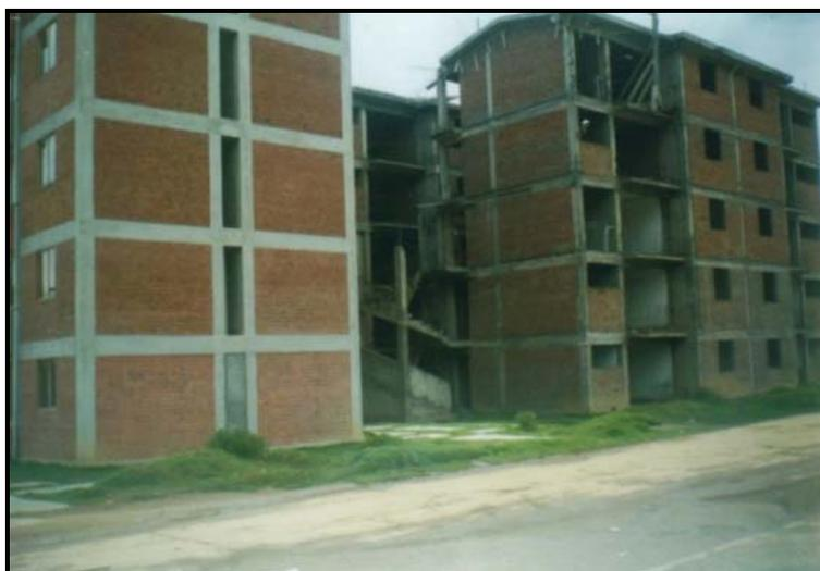
**Figura N° 4.30** Edificio Multifamiliar en Huancayo de albañilería confinada.
