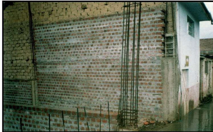
**Figura N° 4.16** Armadura en columnas (8 varillas de 5/8”).
