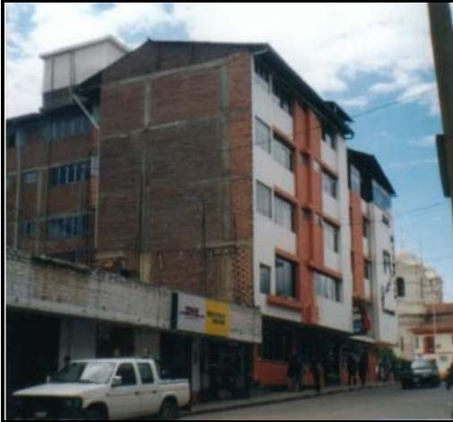
**Figura N° 4.27** Edificio de 5 niveles de albañilería confinada.
