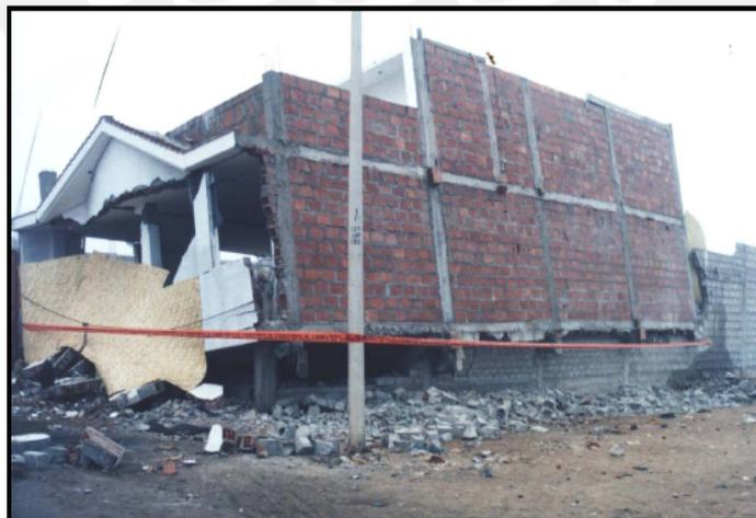
Figura N° 1.1. Colapso de edificación de albañilería (Tacna-2001)
