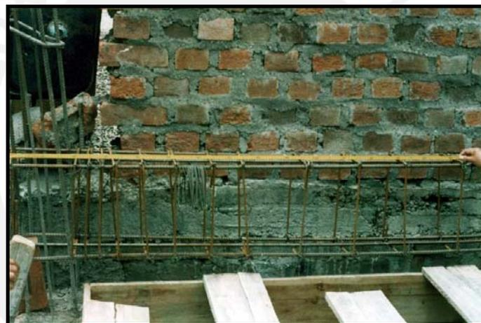
**Figura N° 4.18** Armadura en vigas, nótese confinamiento  $L = 0.5m$ .
