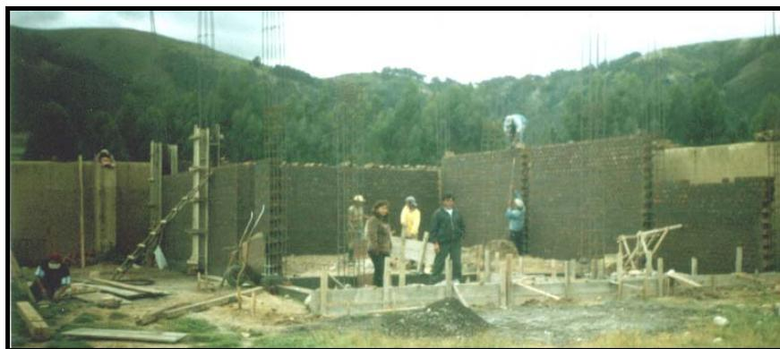
**Figura N° 4.14** Nótese el peralte de las columnas en el encofrado.
