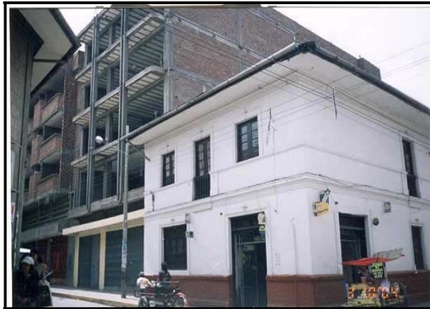
**Figura N° 4.44** Edificio con ladrillo pastelero en muros en voladizo.
