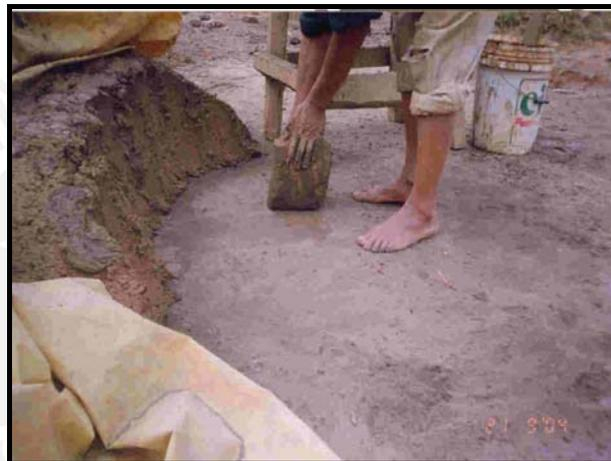
Figura N° 2.8. Separado de una porción de barro y empapado con arena
