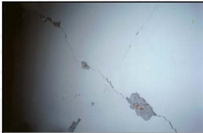
**Figura N° 1.3.** Típica falla a corte en vivienda (Arequipa-2001)
