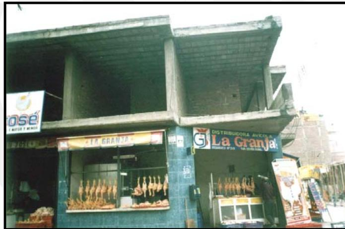
Figura N° 4.15 Losa aligerada en un sentido y solera de espesor igual a la losa.
