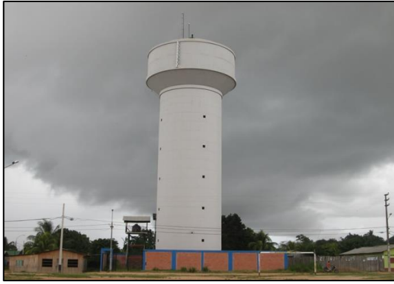
Imagen 10. Tanque elevado de concreto armado.
