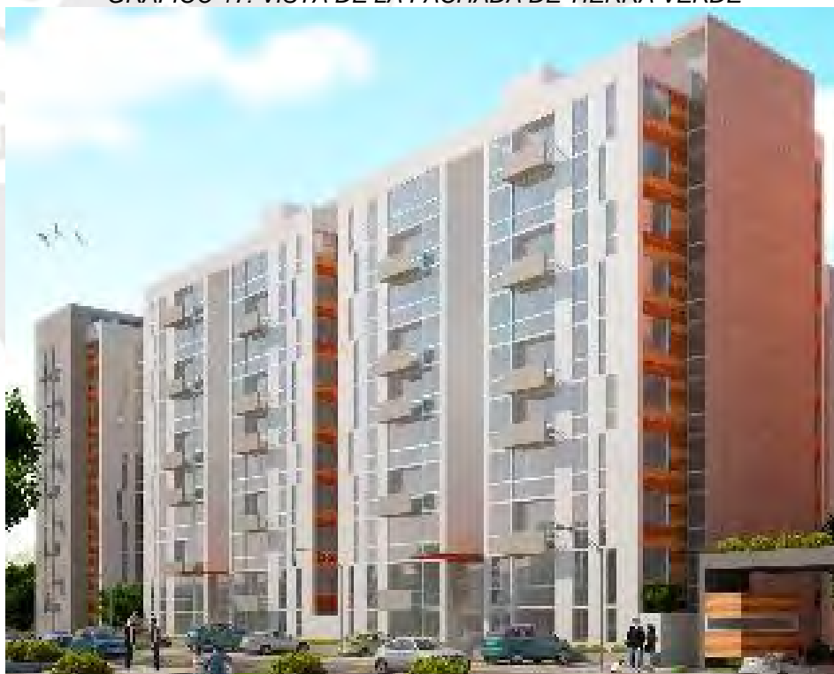
GRÁFICO 17: VISTA DE LA FACHADA DE TIERRA VERDE
