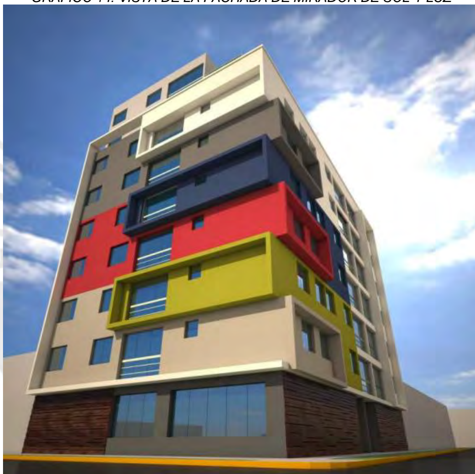
GRÁFICO 14: VISTA DE LA FACHADA DE MIRADOR DE SOL Y LUZ
