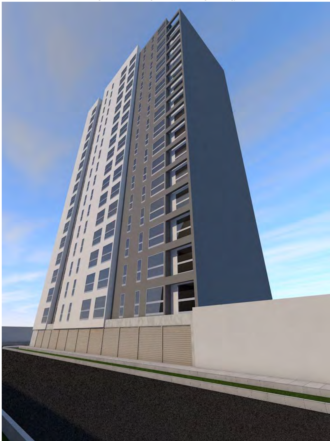
VISTA DE LA FACHADA DE LA CALLE S/N.
