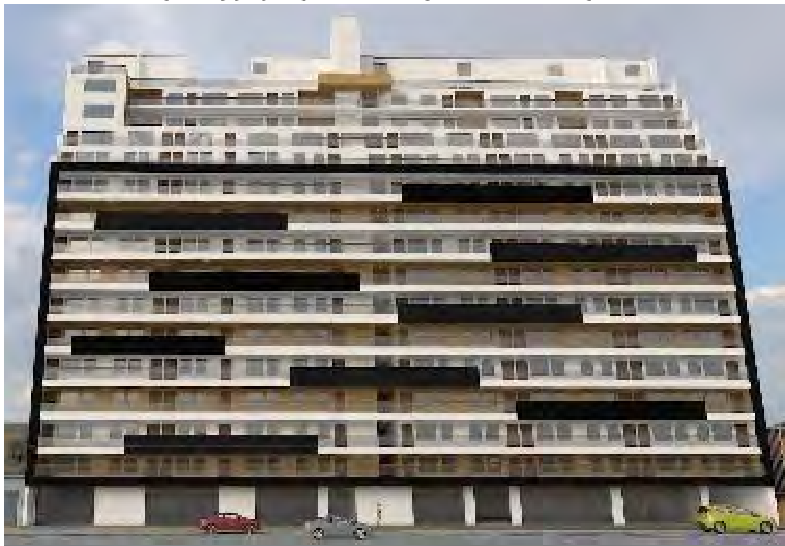
GRÁFICO 19: VISTA DE LA FACHADA DE ALBRECHT II
