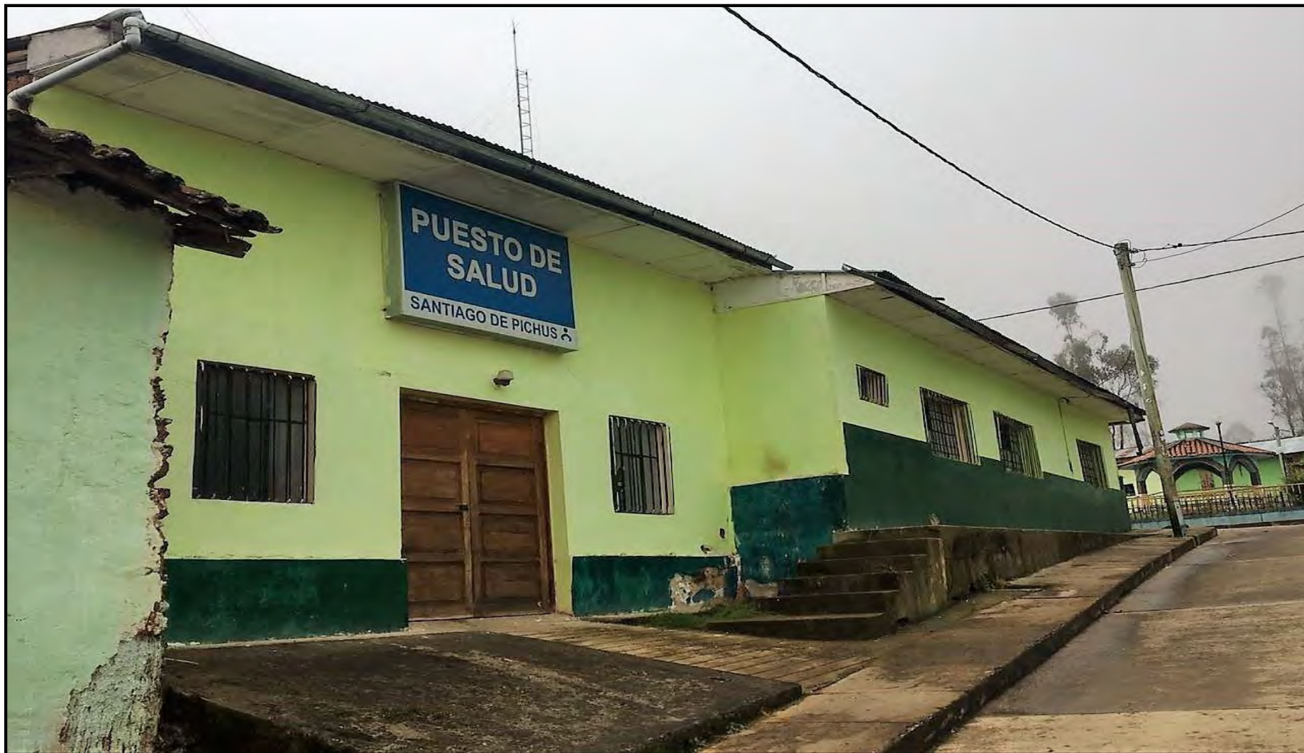
Figura 02: Antigua infraestructura del centro de salud Santiago de Pichus
