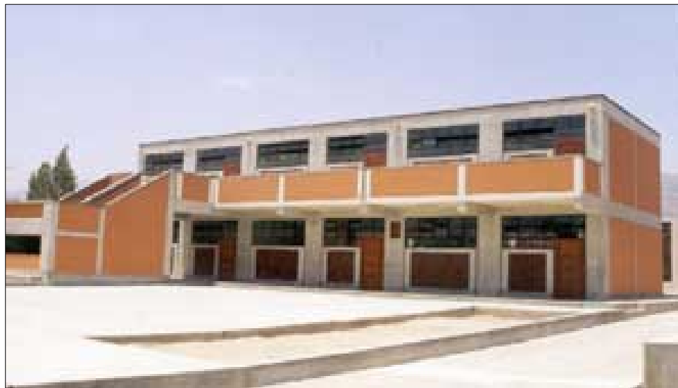
Figura 4.7 Edificio 780 actual de 3 aulas por piso en la costa peruana
