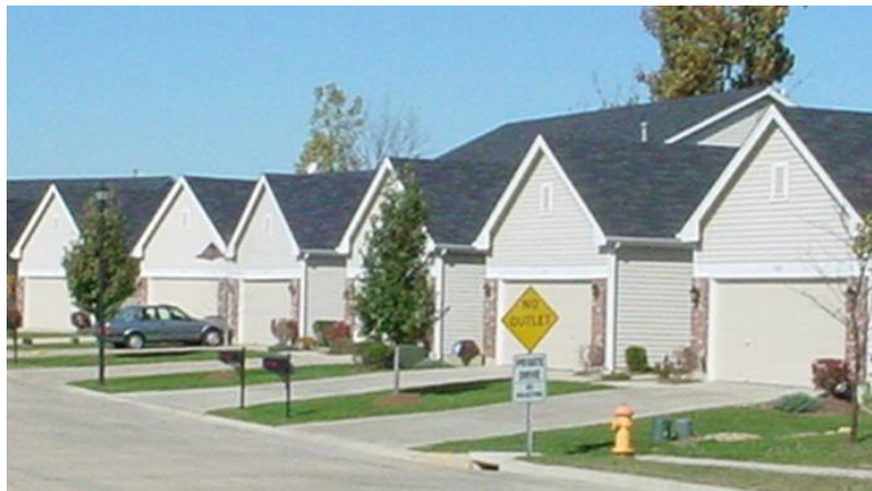
Figura 3.11 Viviendas con similares características arquitectónicas y estructurales.
