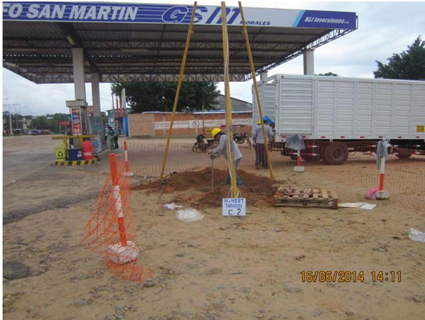
UBICACIÓN DE LA CALICATA C-2. SE APRECIA EL EQUIPO DE PERFORACIÓN IWAN AUGER UTILIZADO PARA PROFUNDIZAR LA CALICATA.
