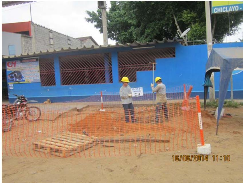
PROFUNDIZACIÓN DE LA CALICATA C-3 CON PERFORACIÓN CON IWAN AUGER.
