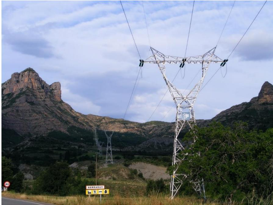
**Figura 3.2. Torre de 220kV tomada de referencia para los cálculos.**
