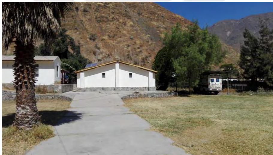
Imagen 19: Vista actual del centro de atención de salud
