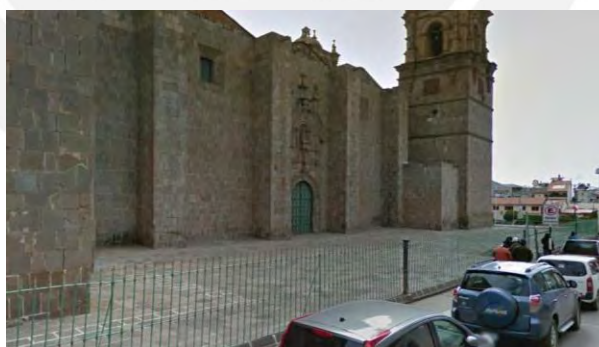
Figura 3.8. Muros y contrafuertes de la nave central
