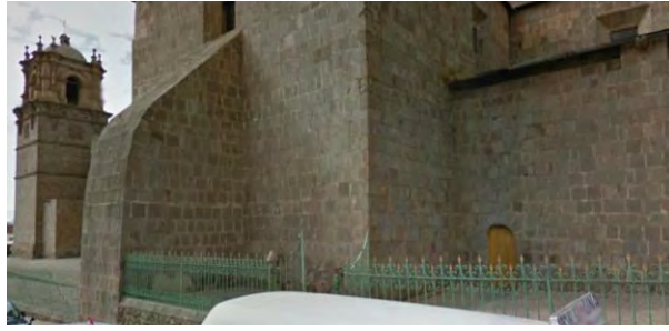
Figura 3.11. Mampostería con aparejo regular en la Catedral de Puno
