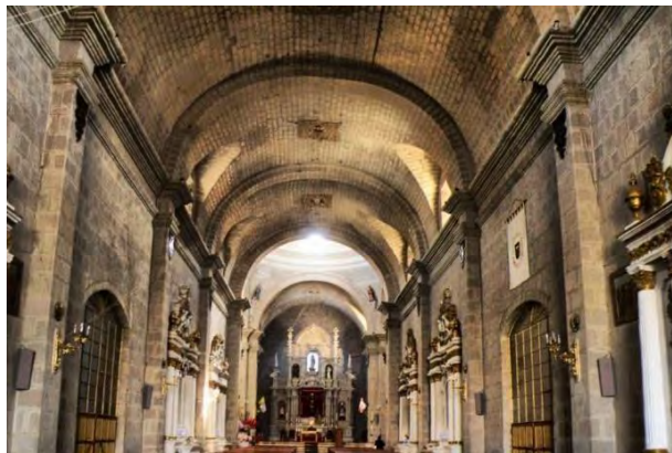
Figura 3.9. Bóveda de cañón corrido de la catedral de Puno
