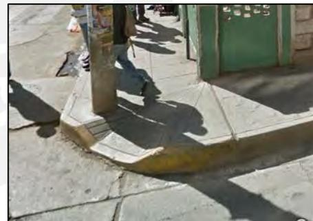
Figura 8. Rampa de pendiente pronunciada con obstáculo
