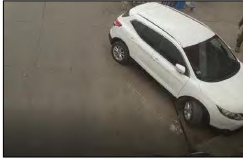
Figura 26. Demarcación desgastada de estacionamientos
