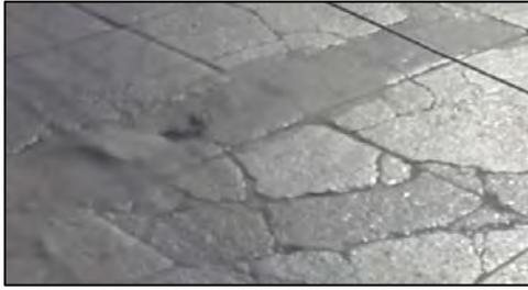
Figura 18. Deterioro en la superficie de rodadura
