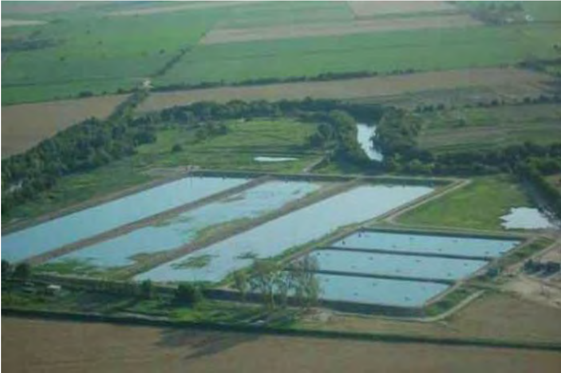
Fotografía 2: Laguna de estabilización
